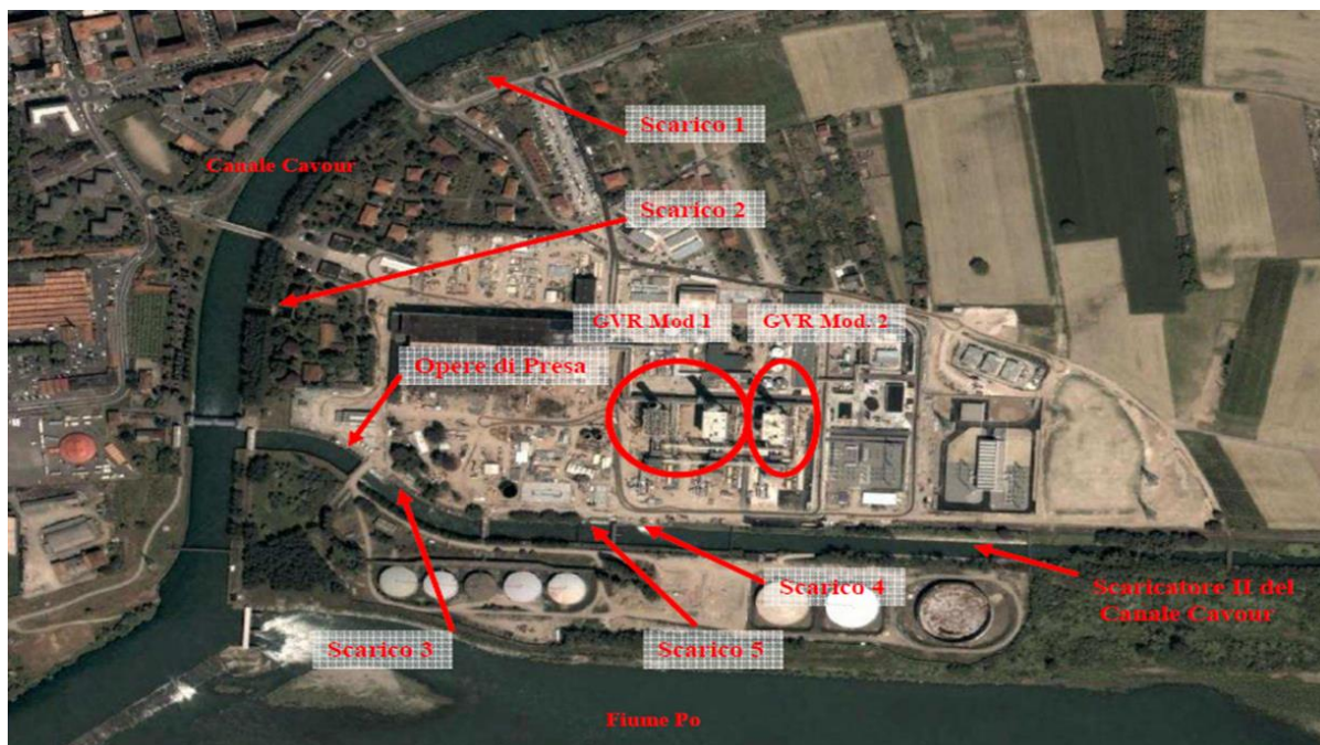
Fig.5 Opere di presa e restituzione delle acque di raffreddamento nel fiume Po e nel canale Cavour
