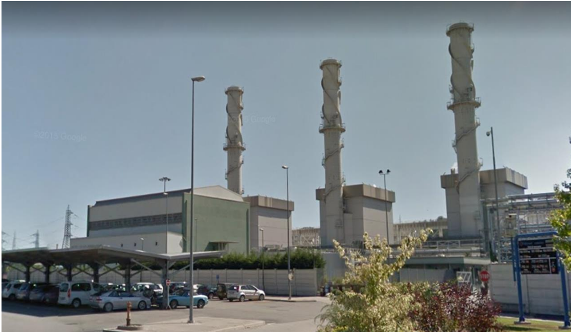
Fig.4a Vista dal piazzale di ingresso dell'impianto termoelettrico CCGT di Chivasso (To)
