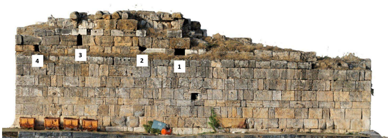
Figura 59, muro di fondo del Ninfeo, lato est, ortofoto da modello 3D, dettaglio delle cavità.
