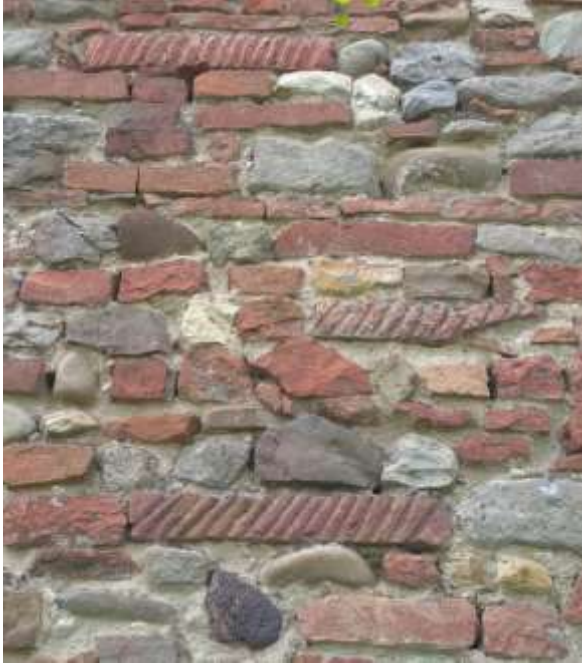
Fig. 11. Sarezzano, église SS. Ruffino e Venanzio. Briques du haut Moyen Âge réemployés dans les murs de l'église actuelle. Photo par V. Sala 2021
