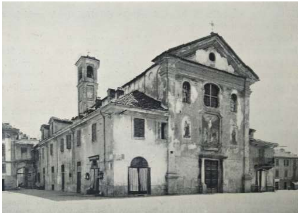
Fig. 8. Acqui, église dell'Addolorata avant les travaux du 1927. MESTURINO 1933, p. 40.
