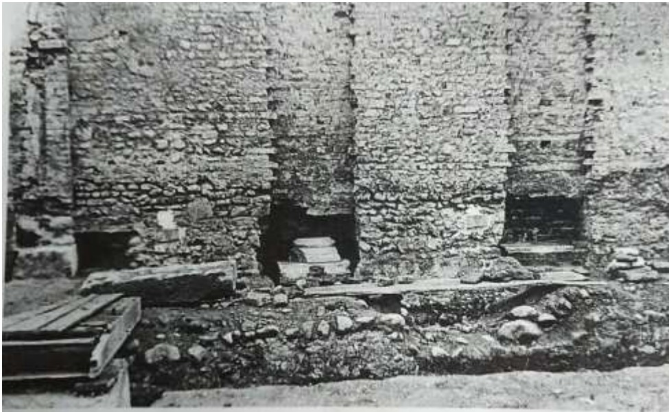
Fig. 14. Collegno, église San Massimo. Mur de l'église après la démolition partielle des piliers romans et découverte des bases des colonnes. CROSETTO 2004, p. 254, p. 208.
