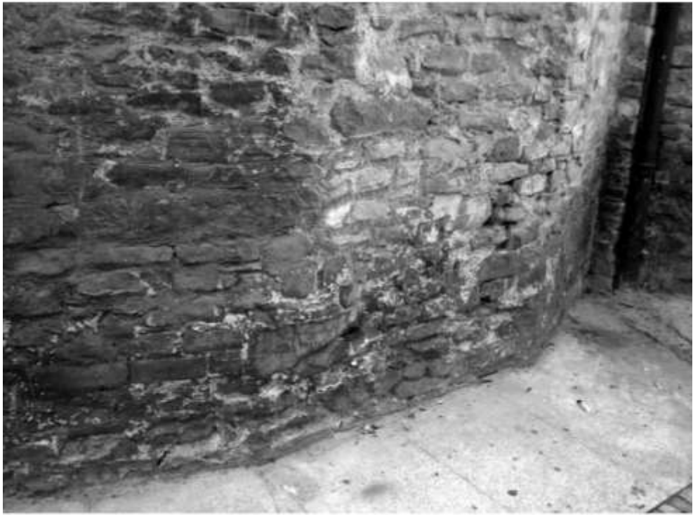
Fig. 13. Acqui, Basilica dell'Addolorata (San Pietro). Fondations de l'abside méridionale. CROSETTO 2013, p. 82, fig.3.
