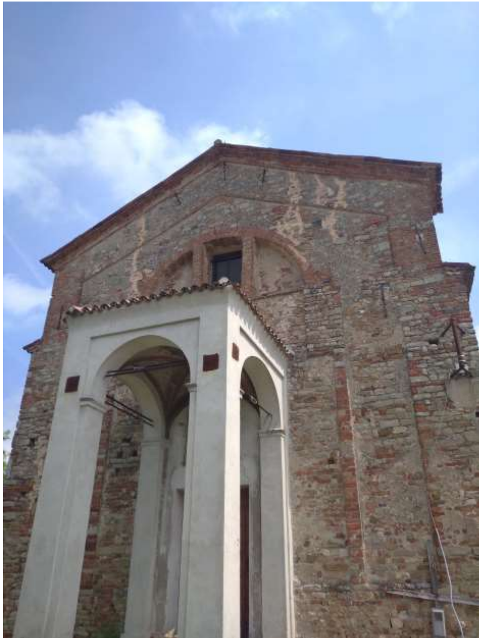
Fig. 3. Sarezzano, église SS. Ruffino et Venanzio. Façade de l'église actuelle avec les restes des murs romans. Photo V. Sala 2021.
