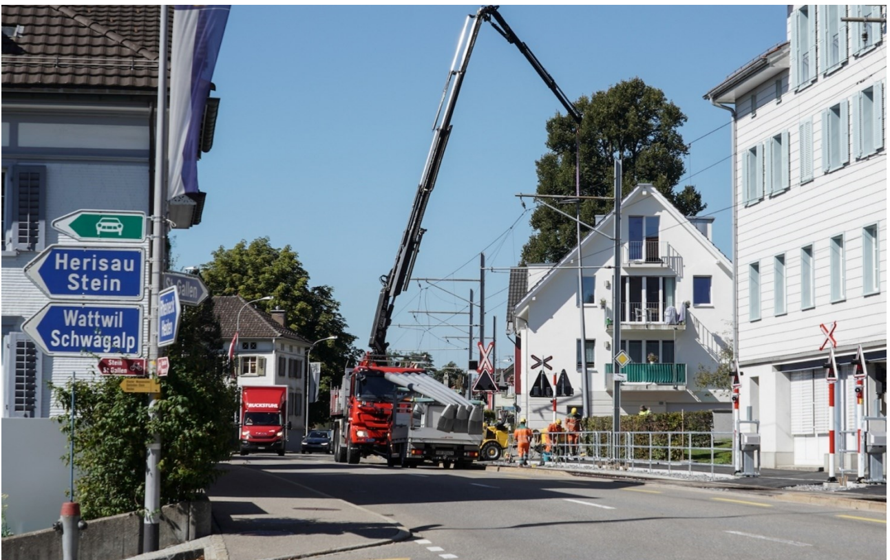
Figura 3.21 - Teufen: lavori di installazione dei sostegni della linea di contatto
