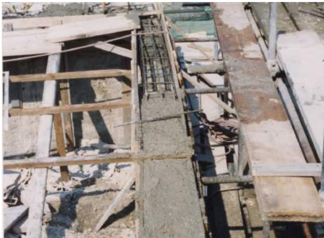
Fig. 42/ La realizzazione del cordolo in cemento armato sul muro dell'aula (Archivio Trinchi).
