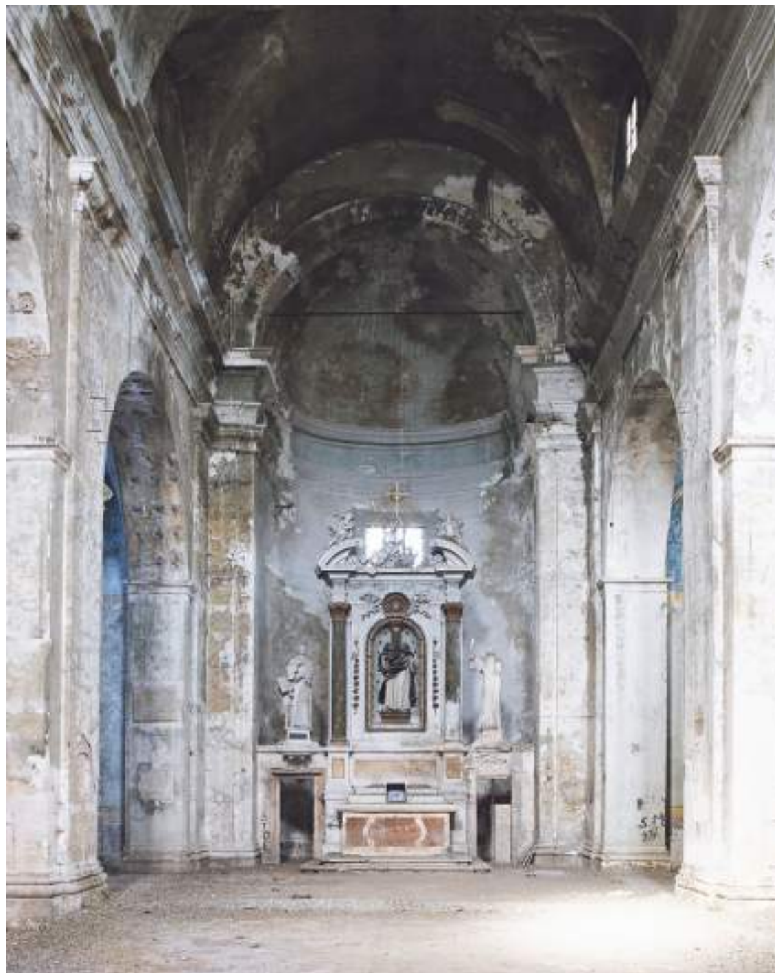
Fig. 21/ Vista dell'aula della chiesa coperta a volta a botte, con cappelle laterali e altare a diaframma.
