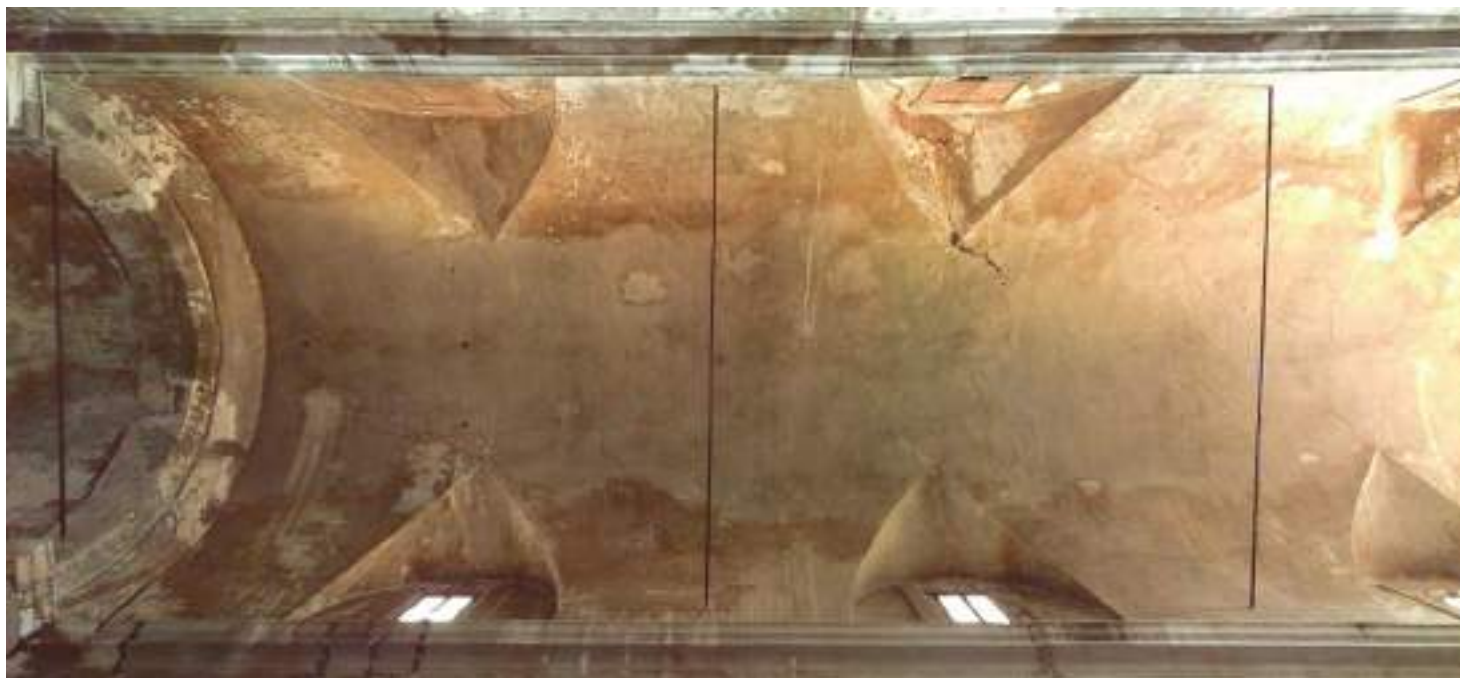
Fig. 10/ Vista dal basso della volta con lunette sferoidali. Per ognuna è presente una finestra, tamponate quelle sul lato sinistro della chiesa (in alto nella foto) per la presenza della Sala Severi.
