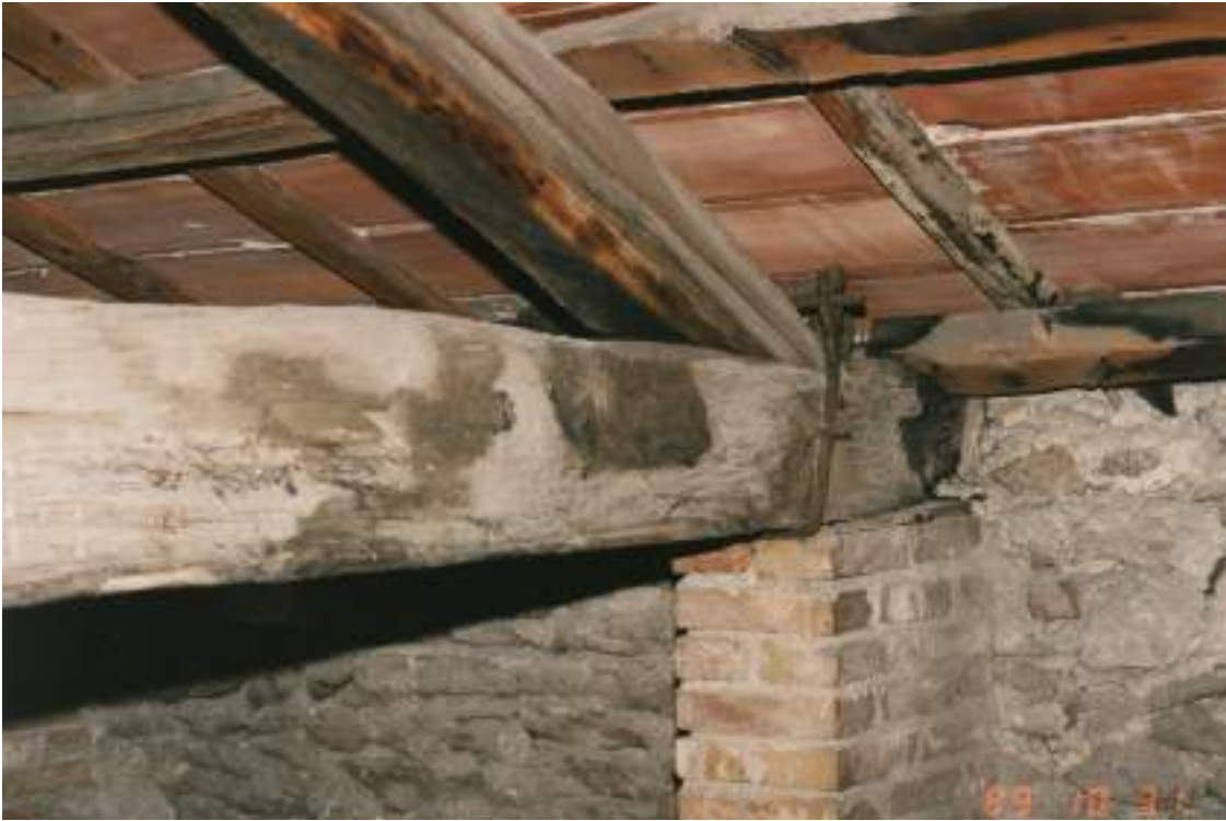
Fig. 45/ Dettagli delle vecchie capriate lignee (Archivio Trinchi).
