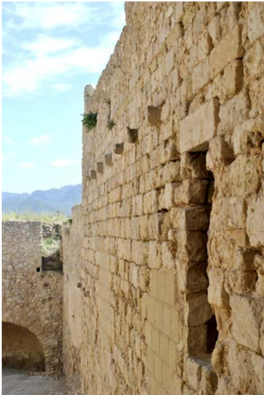
Fig. 22. Castillo de Miravet, Ménsulas del lado externo del refectorio. Fuente: Autor
