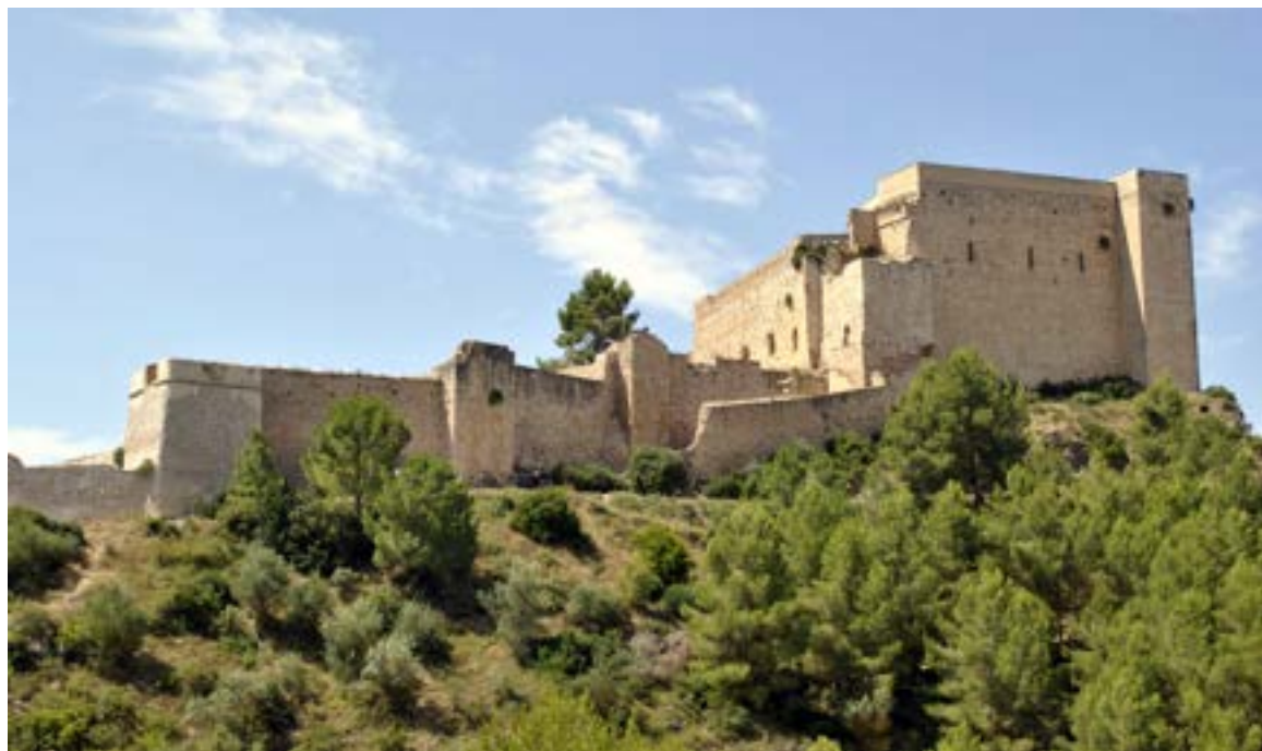
Fig. 13. Castillo de Miravet, Lado norte. Fuente: Autor
