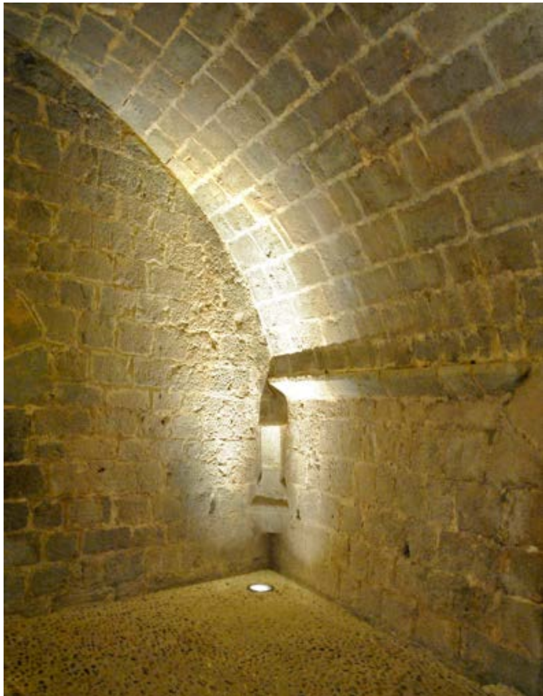
Fig. 30 Castillo de Peñíscola, Nivel inferior, ménsula en el ángulo del Cuerpo de guardia . Fuente: Autor
