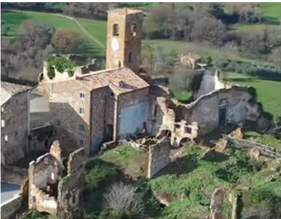
Fig 31. Area di intervento. Foto del dipartimento di Ingegneria Edile Architettura della Sapienza
