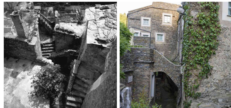
Fig. 16. Colletta di Castelbianco. Asx prima dell'intervento di recupero, a destra come la possiamo vedere oggi
