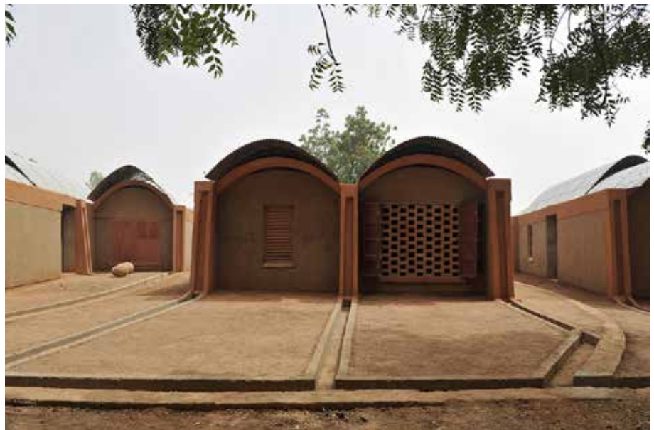
Fig. 10 Diébédo Francis Kéré, Alloggi per gli insegnanti a Gando, Burkina Faso, 2004. © Erik-Jan Ouwerkerk
