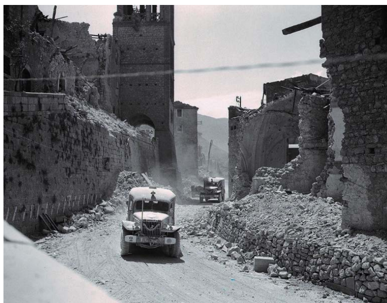
Figura 2.5 – Maggio 1944, Vallecorsa. La strada raffigurata è via Roma. Il campanile sulla sinistra è quello della chiesa di Santa Maria, mentre sulla destra spiccano le rovine dell'abside della chiesa di Sant'Antonio. Fonte: Archivio DVAC, al sito www.dalvolturnoacassino.it/asp/n_main.asp .
