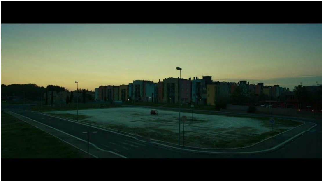
FIG. 2.1 La terra dell'abbastanza , immagine del quartiere di Ponte di Nona
