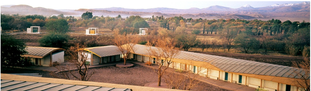
Fig. 112. G. Del Sol, Hotel Explora Atacama, San Pedro de Atacama, 2000
