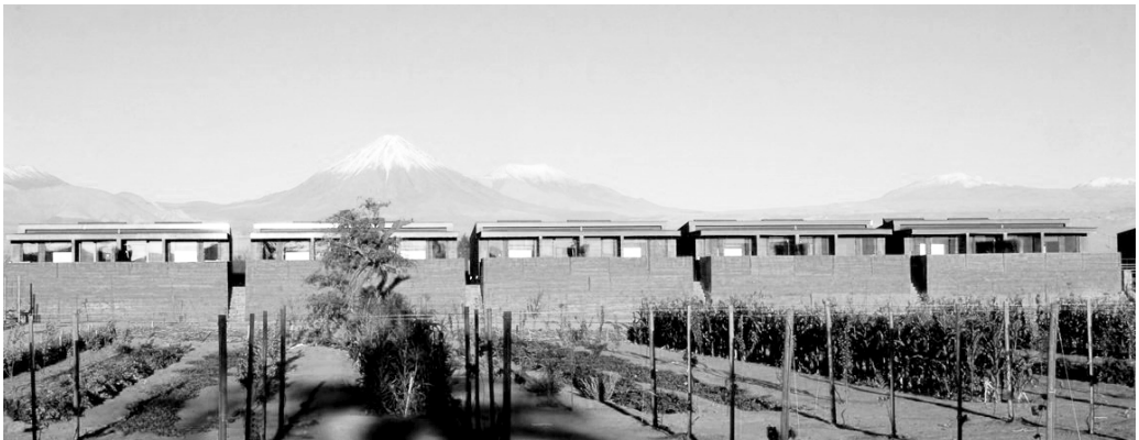
Fig. 36. M. González e R. Searle, Hotel Tierra Atacama, San Pedro de Atacama, 2007-2008
