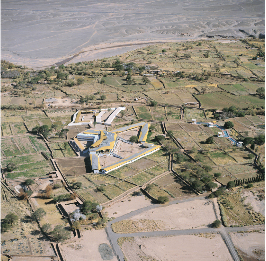
Fig. 111. G. Del Sol, Hotel Explora Atacama, San Pedro de Atacama, 2000
