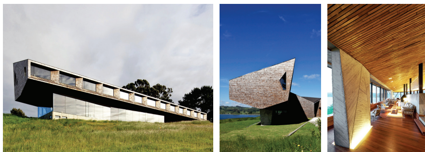
Fig. 185-186-187. Mobil Arquitectos, Refugia Hotel, Dalcahue, 2011
