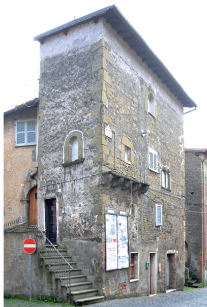
Fig. 2. Foto della facciata in via del Borgo (2021).
