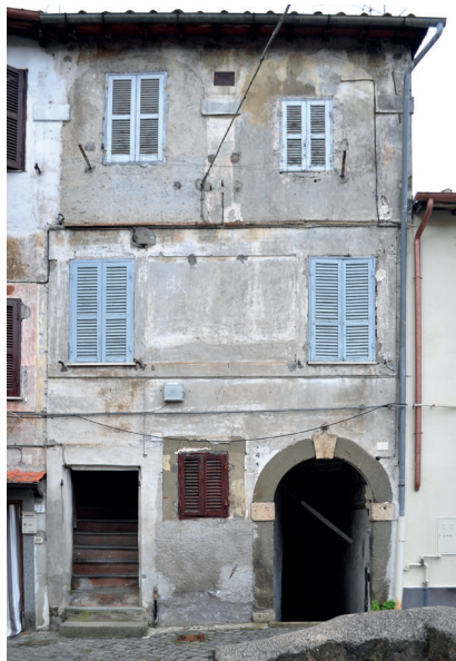
Fig. 3. Foto della facciata in via del Senile (2021).
