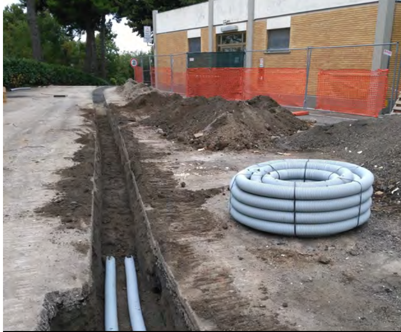
Figura 33 – Scavo per posa tubazioni e corrugati per collegamenti elettrici.
