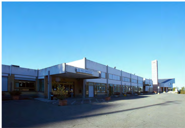
Figura 8 – Edificio E (Diurno).
