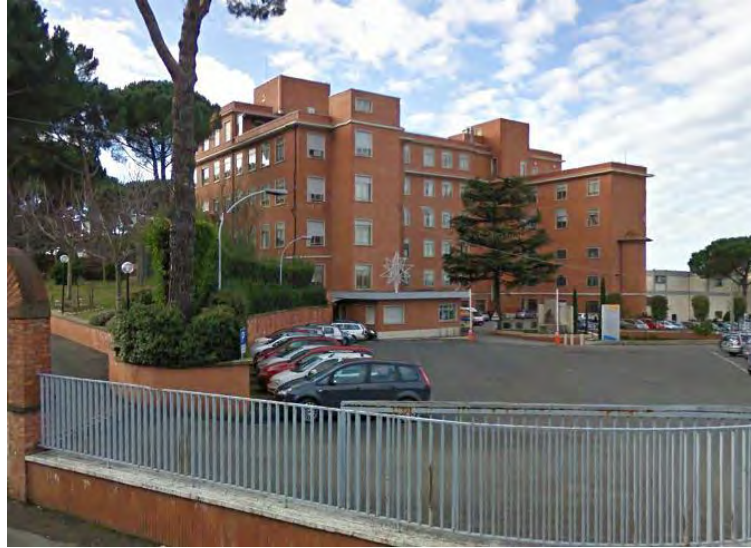
Figura 7 – Edificio A - Prospetto Nord-Est.
