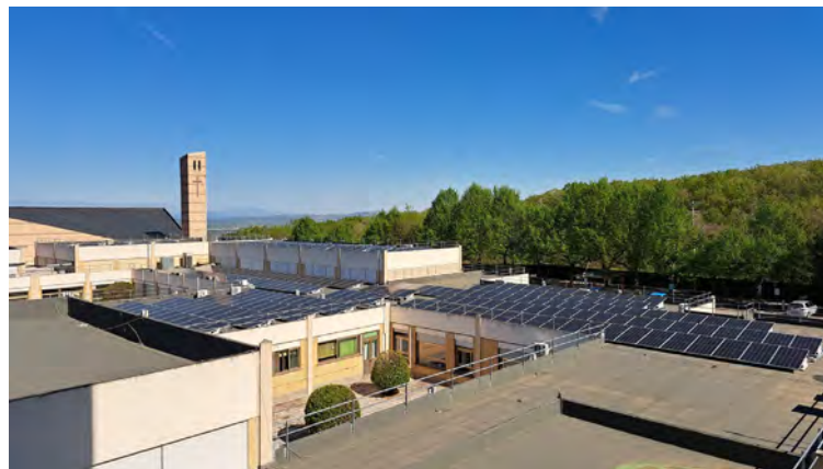
Figura 55. Vista della disposizione dei pannelli installati in copertura del Centro Diurno.
