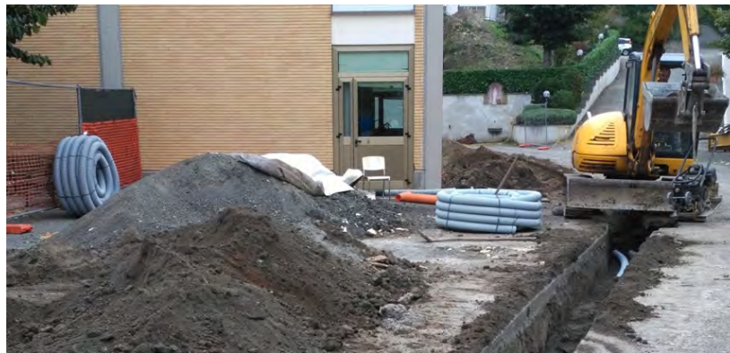
Figura 34 – Scavo per posa tubazioni.
