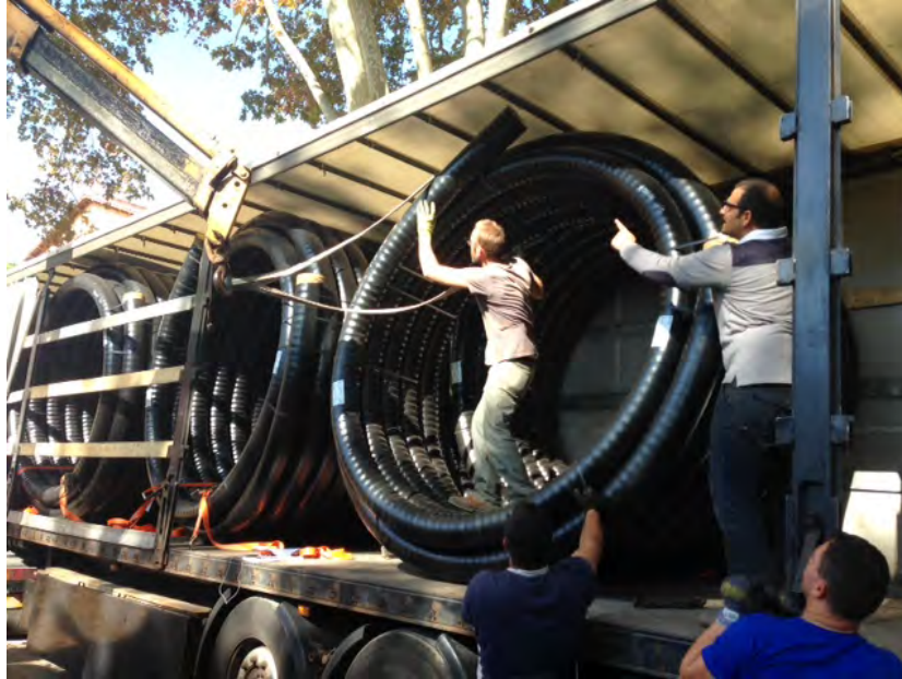
Figura 31 – Tubo CALPEX in arrivo in cantiere.
