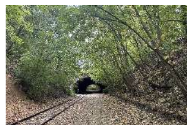
FIG. 4.22 - Imbocchi In Gallerie © P. Amato
