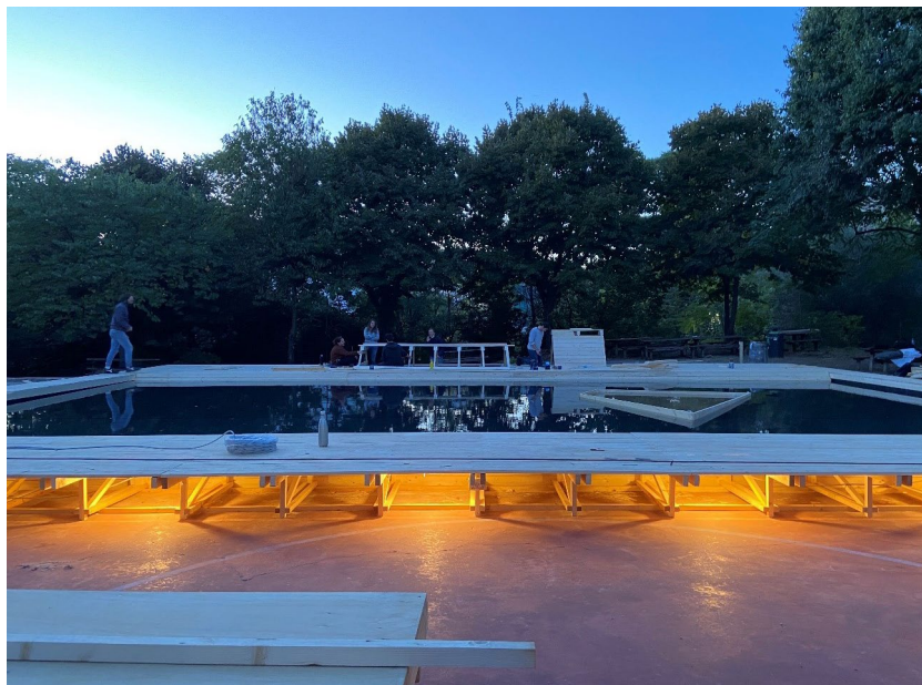
Figura 65. AIM - Architettura In Mobilitazione e Orizzontale. Workshop CENTO. Installazione dei dispositivi di illuminazione. Foto dell'autrice
