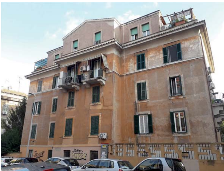
Fig. 3 – Casa per baraccati: via Adalberto, quartiere Sant'Ippolito
