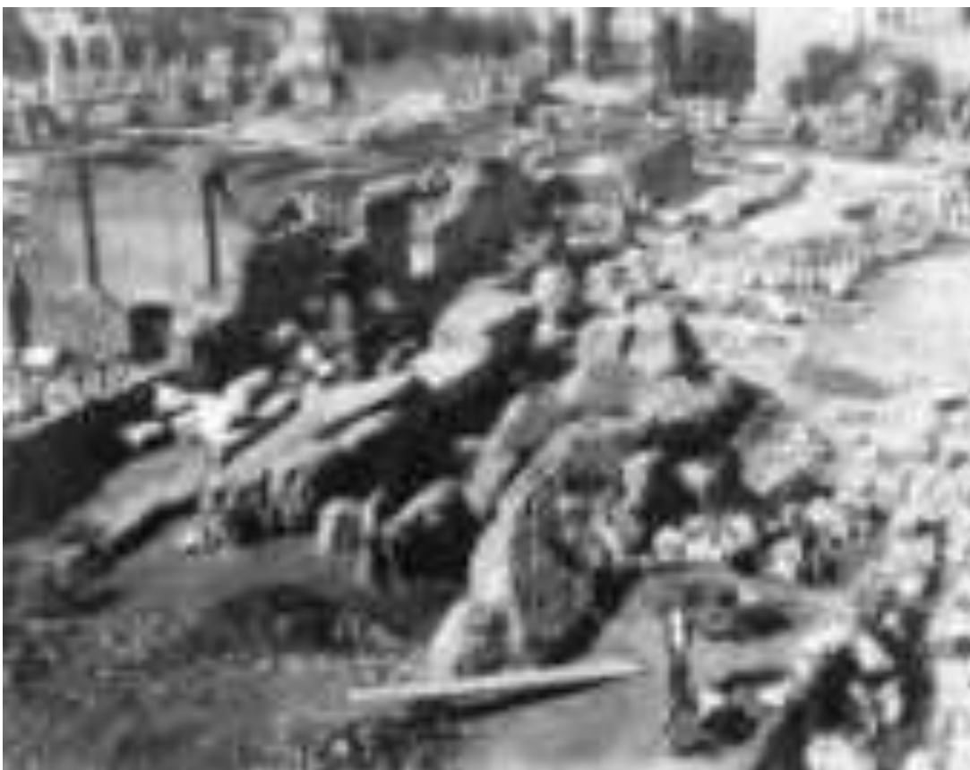
Fig. 185: Muro meridionale di separazione tra aula e taberne, rinvenuto in crollo all'interno dell'edificio (AFS-PArCo)
