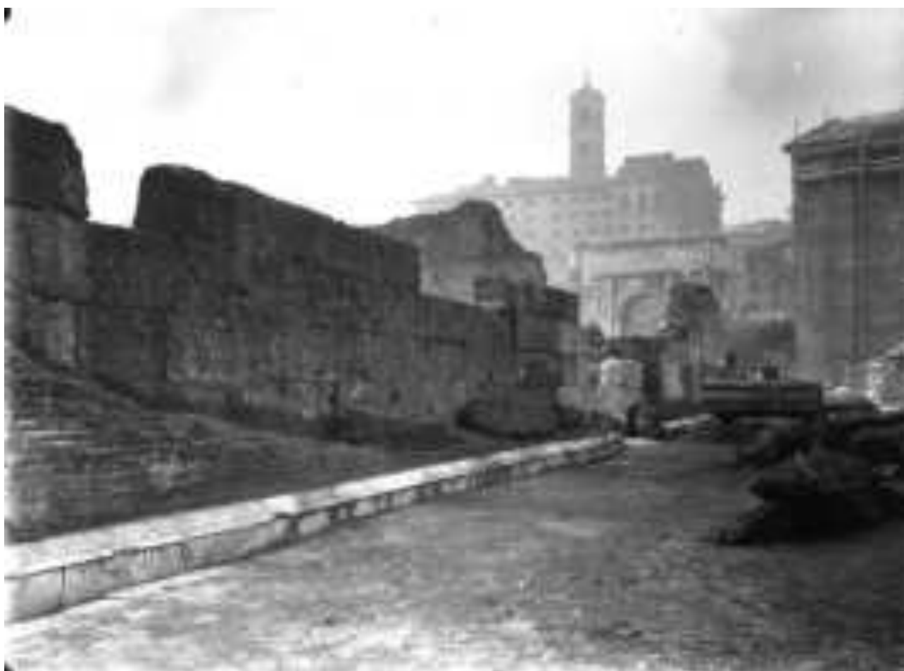
Fig. 68: Veduta del tratto orientale del muro meridionale prima degli interventi di ricostruzione dell'ingresso Est, con in evidenza il filare a blocchi di tufo a cui si addossa la parete in laterizio (AFS-PArCo)
