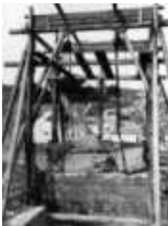
Figg. 213-214: Riposizionamento del muro in opera laterizia e reintegro dei filari inferiori in blocchi di tufo (AFS-PArCo)
