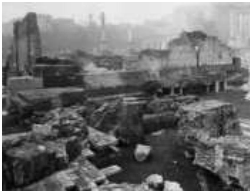
Fig. 58: Tratto di muratura compreso tra l'ingresso orientale e quello centrale, prima degli interventi di ricostruzione. In evidenza il muro a filari di blocchi di tufo a cui è stata addossata la parete in laterizi, rinvenuta in gran parte caduta (AC – in Miranda, Cartella Freyberger)
