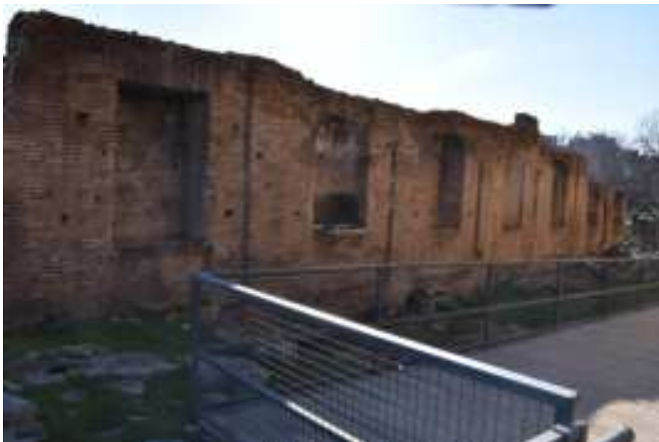
Fig. 94: Lato occidentale della Basilica. Muro in laterizio a nicchie lungo l'Argileto
