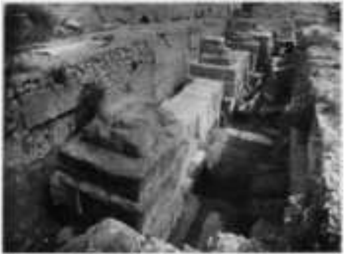
Fig. 138: Fondazione F (Pianta Fig. 25) in blocchi di tufo di Grottaoscura su cui insistono tre basamenti di colonna (AFS-PArCo)
