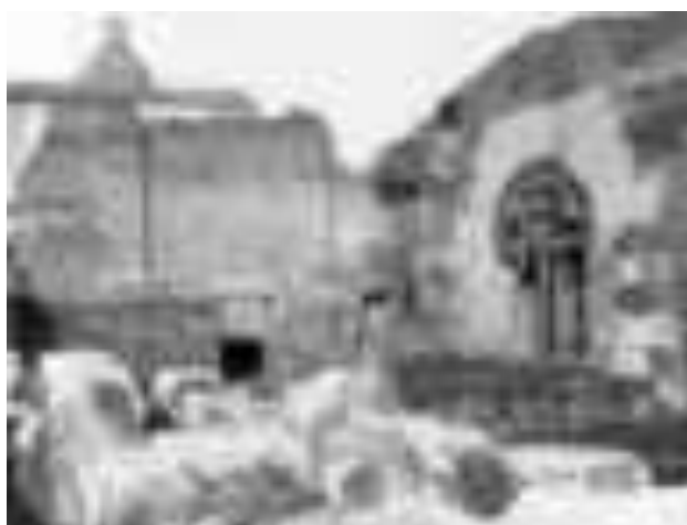
Fig. 205: Lo stato di fatto dell'area subito dopo l'anastilosi dell'ingresso est (appena conclusa, vista la presenza ancora della centina) e prima della demolizione del muro in opera saracena (AFS-PArCo)
