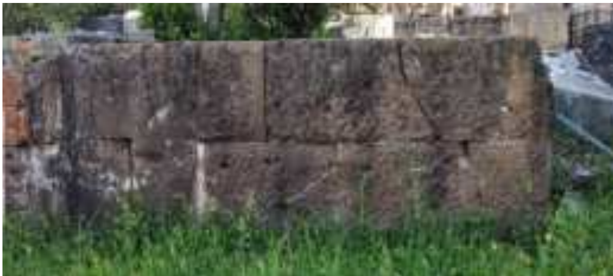
Fig. 90: Muro settentrionale. Tratto a blocchi di tufo con piano ribassato
