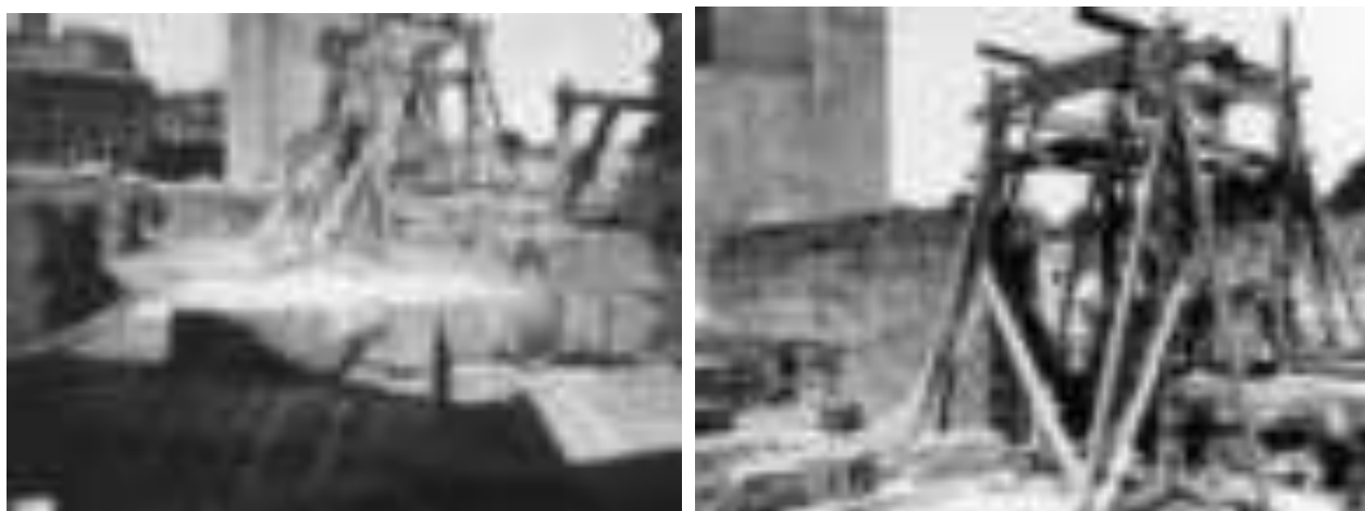
Figg. 211-212: Lavori in corso per il riposizionamento delle murature cadute nell'aula(AFS-PArCo)
