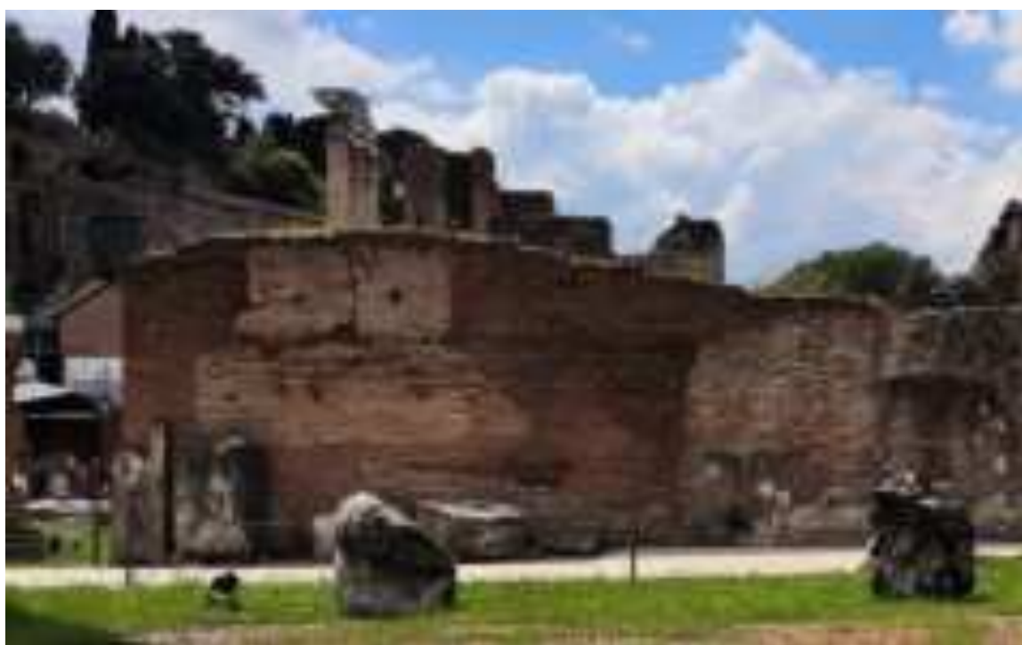
Fig. 53: Muro meridionale. Veduta dall'interno dell'Aula. Tratto parietale a ovest dell'ingresso centrale
