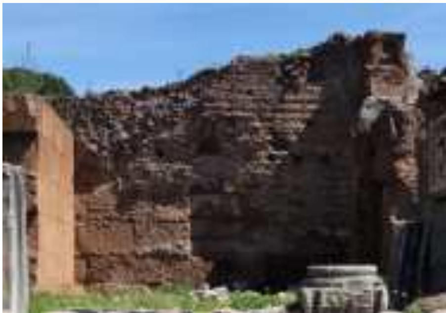
Fig. 60: Muro meridionale. Veduta dal lato taberna. Tratto ad est dell'ingresso centrale
