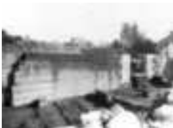
Figg. 215-216: Ricostruzione della parete a blocchi di tufo rivolta verso il lato del Foro e riproposizione dell'ingresso centrale (AFS-PArCo)
