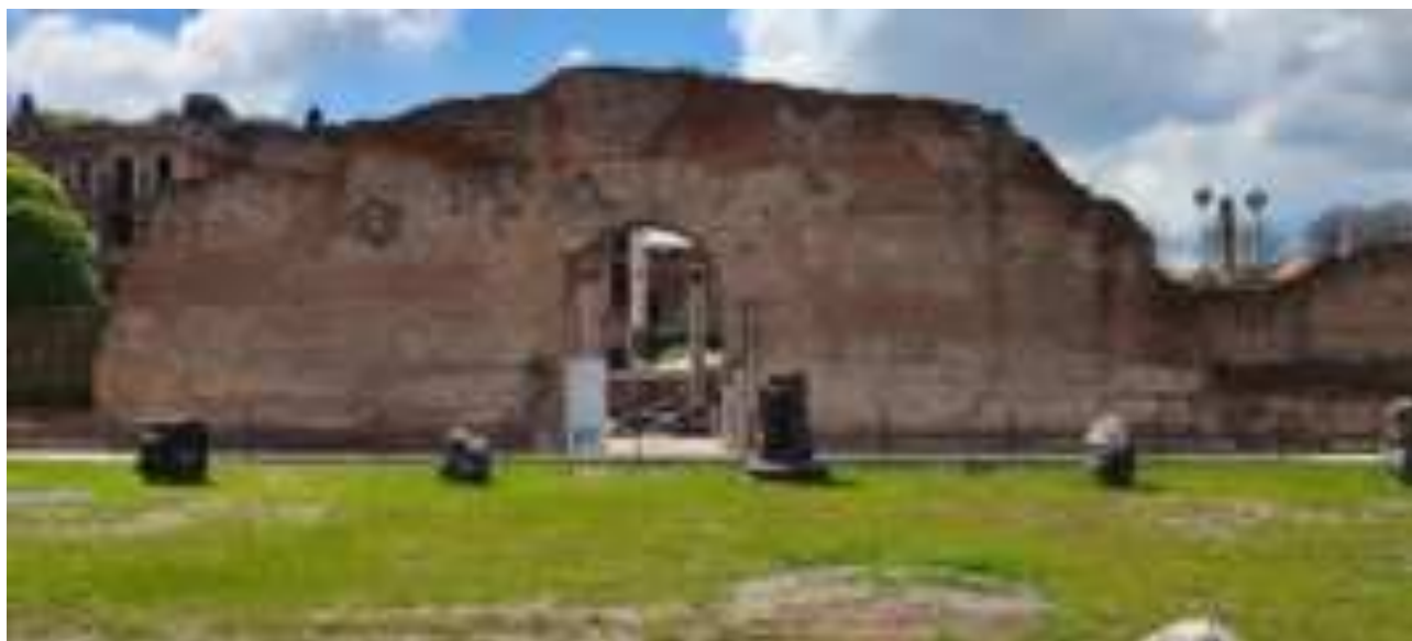
Fig. 63: Muro meridionale. Veduta dall'interno dell'Aula. Tratto in corrispondenza dell'ingresso orientale
