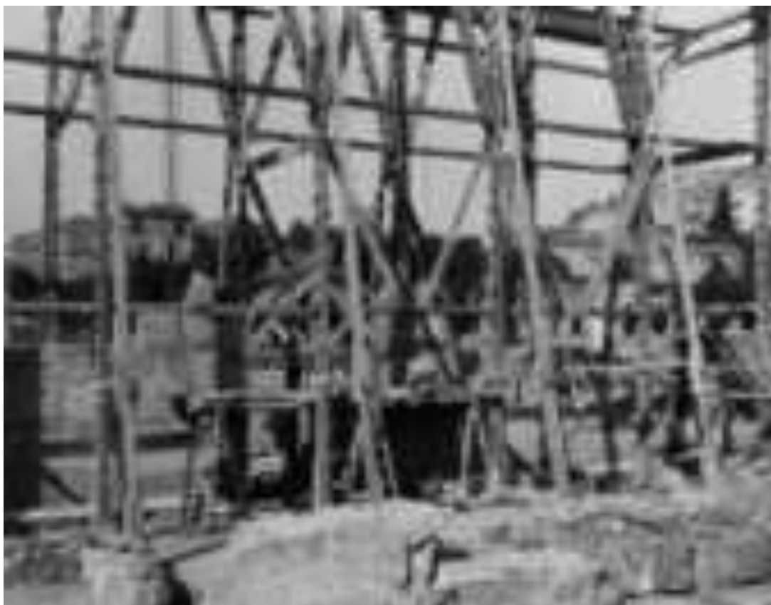
Fig. 200: Anastilosi del muro meridionale. Lavori in corso con visuale dalla parte del Foro(AFS-PArCo)
