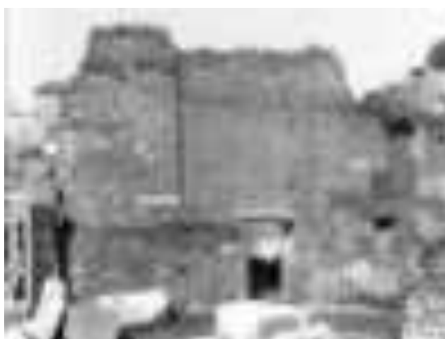
Fig. 203-204: Muro in opera saracena, rispettivamente fronte ovest e fronte est (AFS-PArCo)
