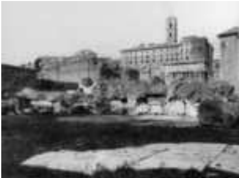
Fig. 186: Muro meridionale di separazione tra aula e taberne, rinvenuto in crollo all'interno dell'edificio (AFS-PArCo)
