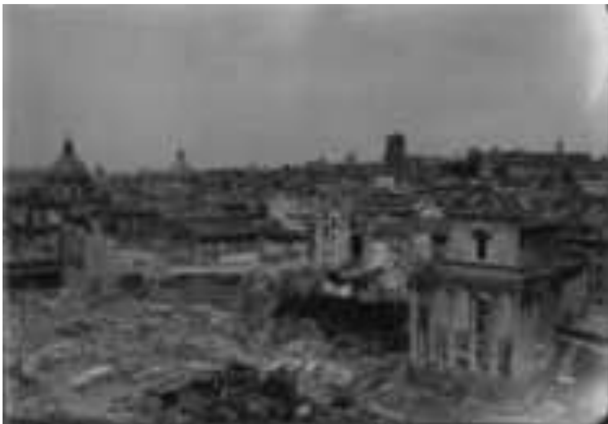
Fig. 120: Veduta dell'area della Basilica Emilia dopo gli scavi del 1899-1900 (AFS-PArCo, 1900 ca.)
