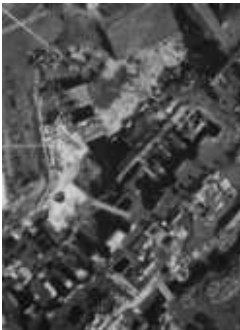
Fig. 119: Ripresa dal pallone aerostatico dell'area scavata della Basilica Emilia (AFS-PArCo, probabilmente autunno 1900)
