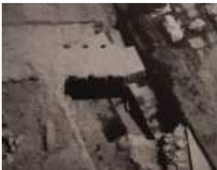
Fig. 77: Blocco di travertino che insiste su filari di tufo giallo, all'altezza della fondazione del muro in cementizio con inclusi in basalto (da Morselli-Tortorici 1990, p. 202, fig. 189)
