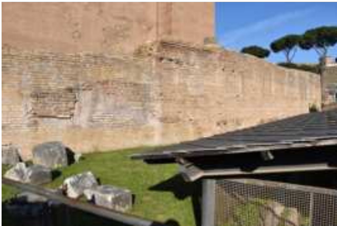
Fig. 96: Lato occidentale della Basilica. Fronte rivolto verso l'Aula
