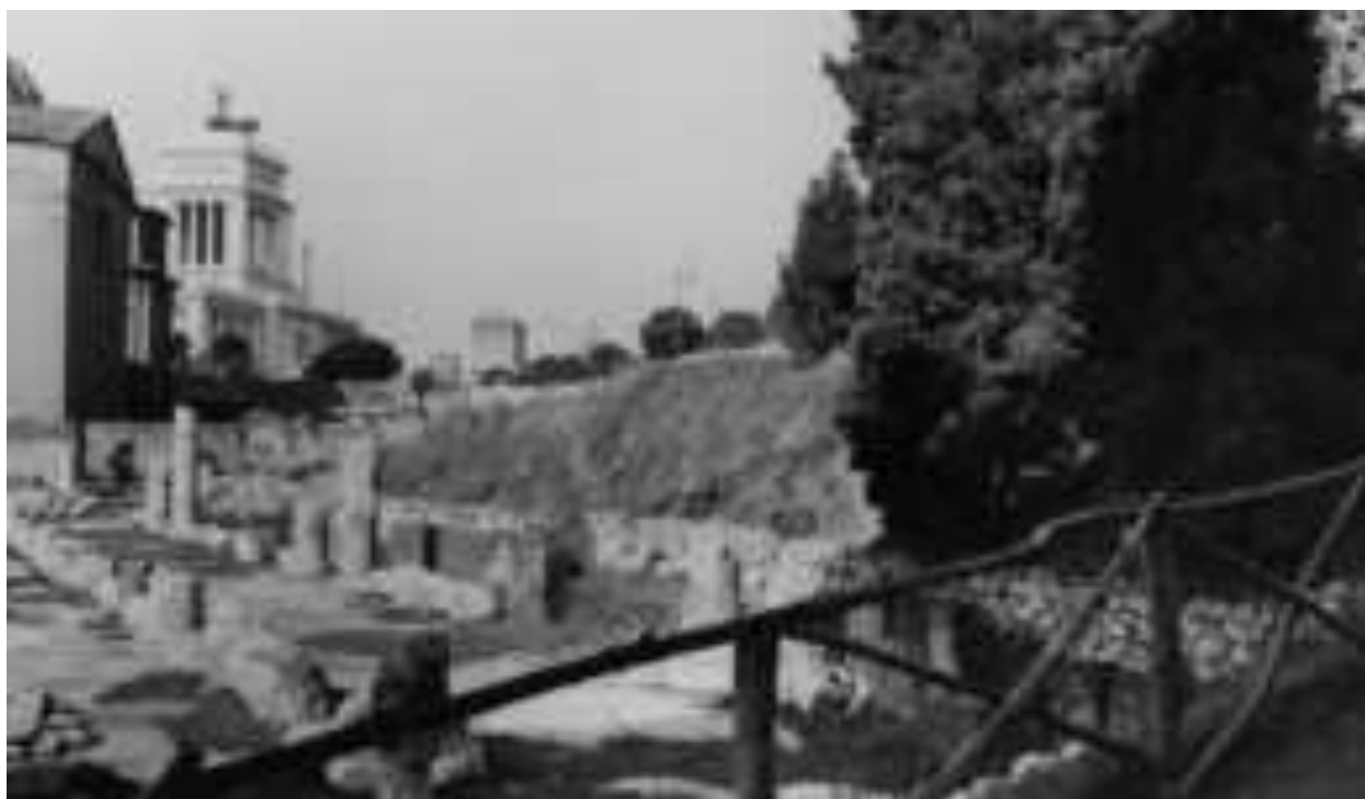
Fig. 85: Veduta da sud-est del muro a blocchi di tufo (AFS-PArCo)
