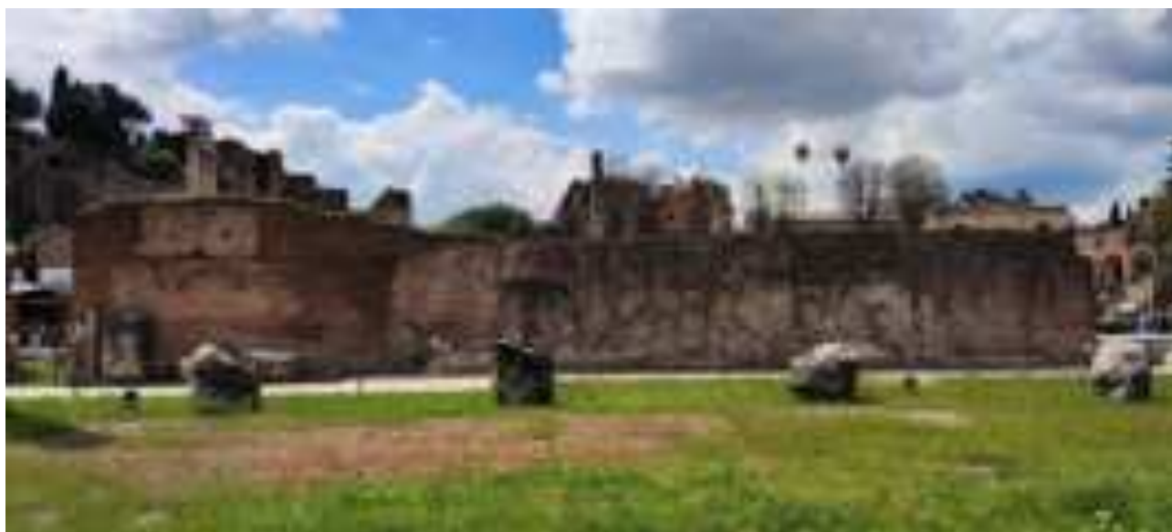
Fig. 48: Muro meridionale. Veduta dall'interno dell'Aula. Tratto compreso tra l'ingresso occidentale e quello centrale
