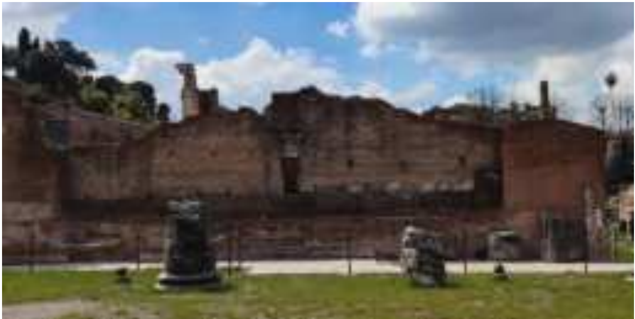
Fig. 59: Muro meridionale. Veduta dall'Aula. Tratto ad est dell'ingresso centrale
