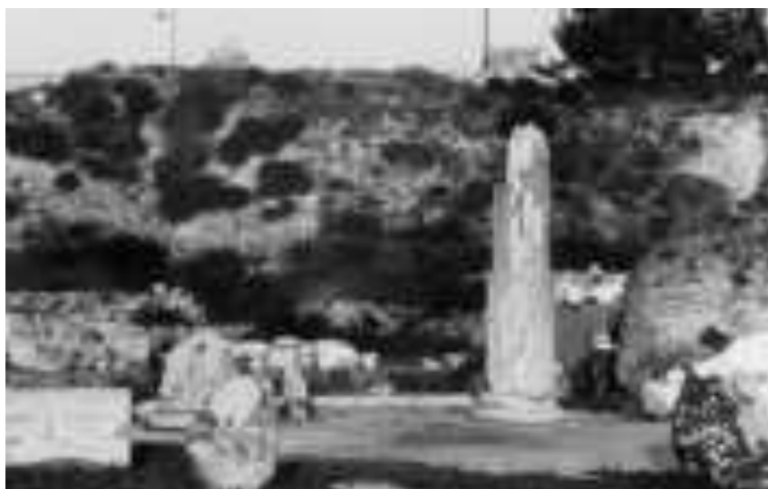
Fig. 86: Muro settentrionale a blocchi di tufo e rivestimento con basamento in giallo antico, prima dei lavori di restauro (AFS-PArCo)
