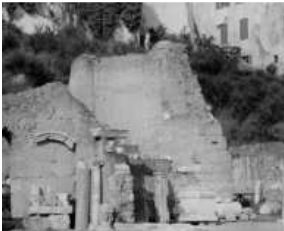
Fig. 32: Edificio medievale (AFS-PArCo)
