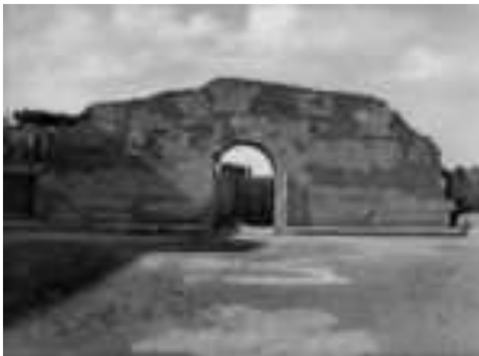
Fig. 202: Anastilosi del muro meridionale appena conclusa. Veduta dall'interno dell'aula (AFS-PArCo)
