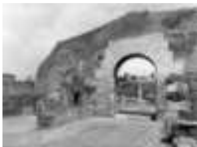
Fig. 205: Lo stato di fatto dell'area subito dopo l'anastilosi dell'ingresso est (appena conclusa, vista la presenza ancora della centina) e prima della demolizione del muro in opera saracena (AFS-PArCo)
