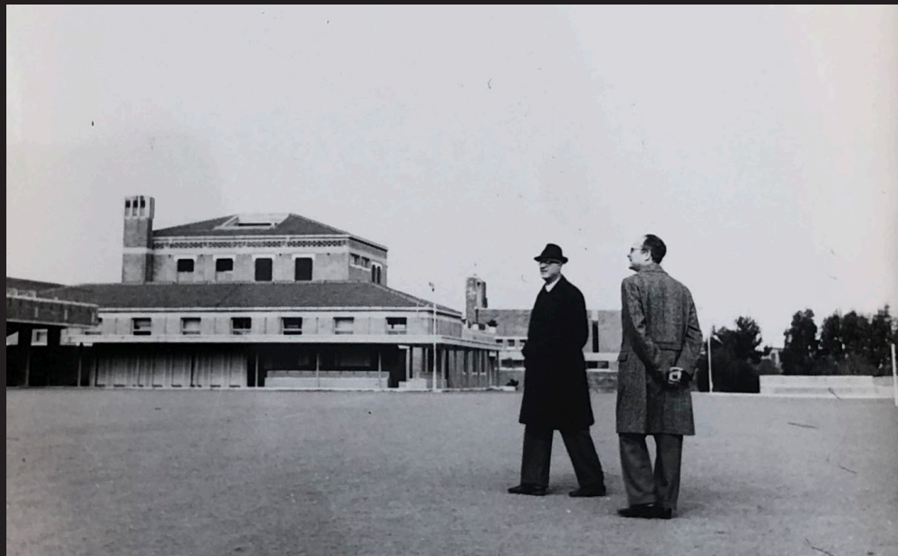
Giulio Paniconi e Mario Pediconi. Collegio Serafico Internazionale di Terra Santa Visita al Cantiere
