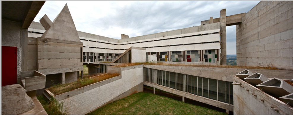
5. Vista del chiostro, Convento La Tourette, intersezione dei corpi e attacco a terra, sulla sinistra l'oratorio con la copertura piramidale.
