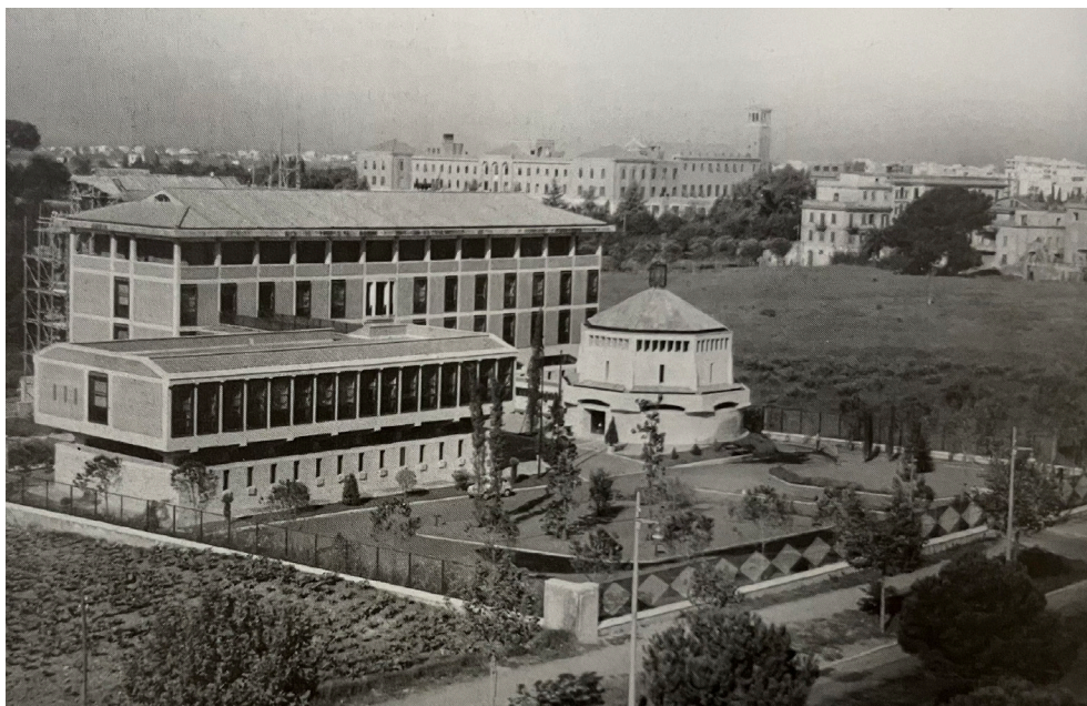
14. L. Vagnetti, Consiglio Centrale dell'Unione Donne di Azione Cattolica, 1958, foto del complesso nel paesaggio urbano
