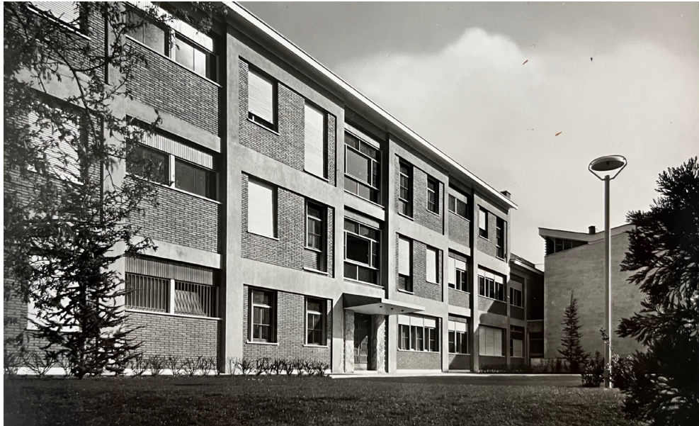
9. Studio Passarelli Curia Generalizia e Collegio Congregazione Santa Croce Vista esterna Edificio Curia Generalizia
