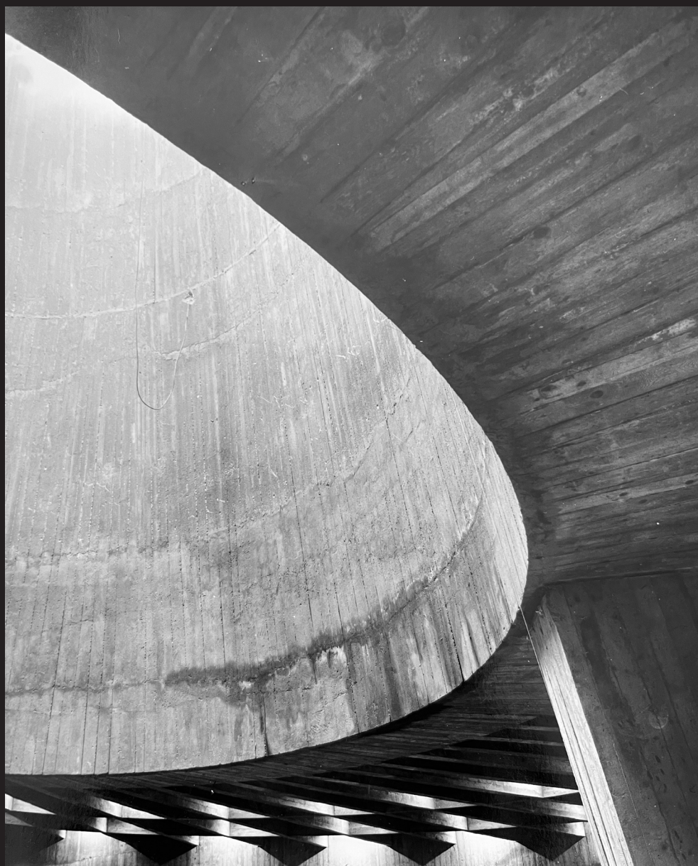
G. Rebecchini, J.Lafuente con Studio Passarelli. Collegio Pio Latino Americano Particolare intradosso solaio cappella
