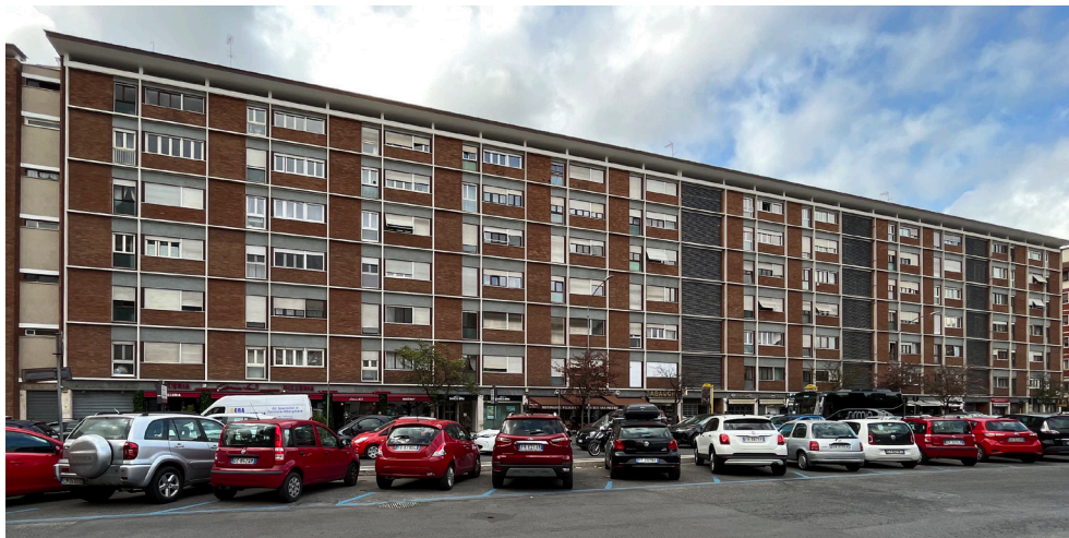
10. Studio Passarelli, Edificio residenziale, 1955, via Gregorio VII.
