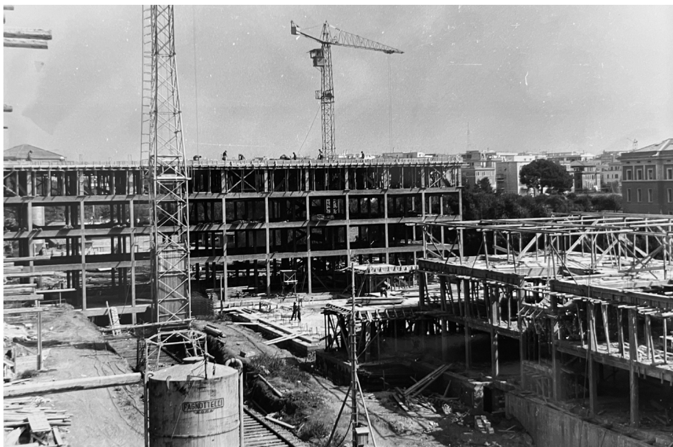
19. G. Rebecchini, J. Lafuente con Studio Passarelli Collegio Pio Latino Amercano Foto del cantiere con scorcio dell'edificato circostante
