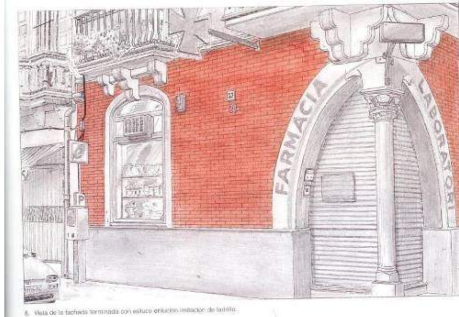
6. Vista de la fachada terminada con estuco enlucido imitación de ladrillo.
