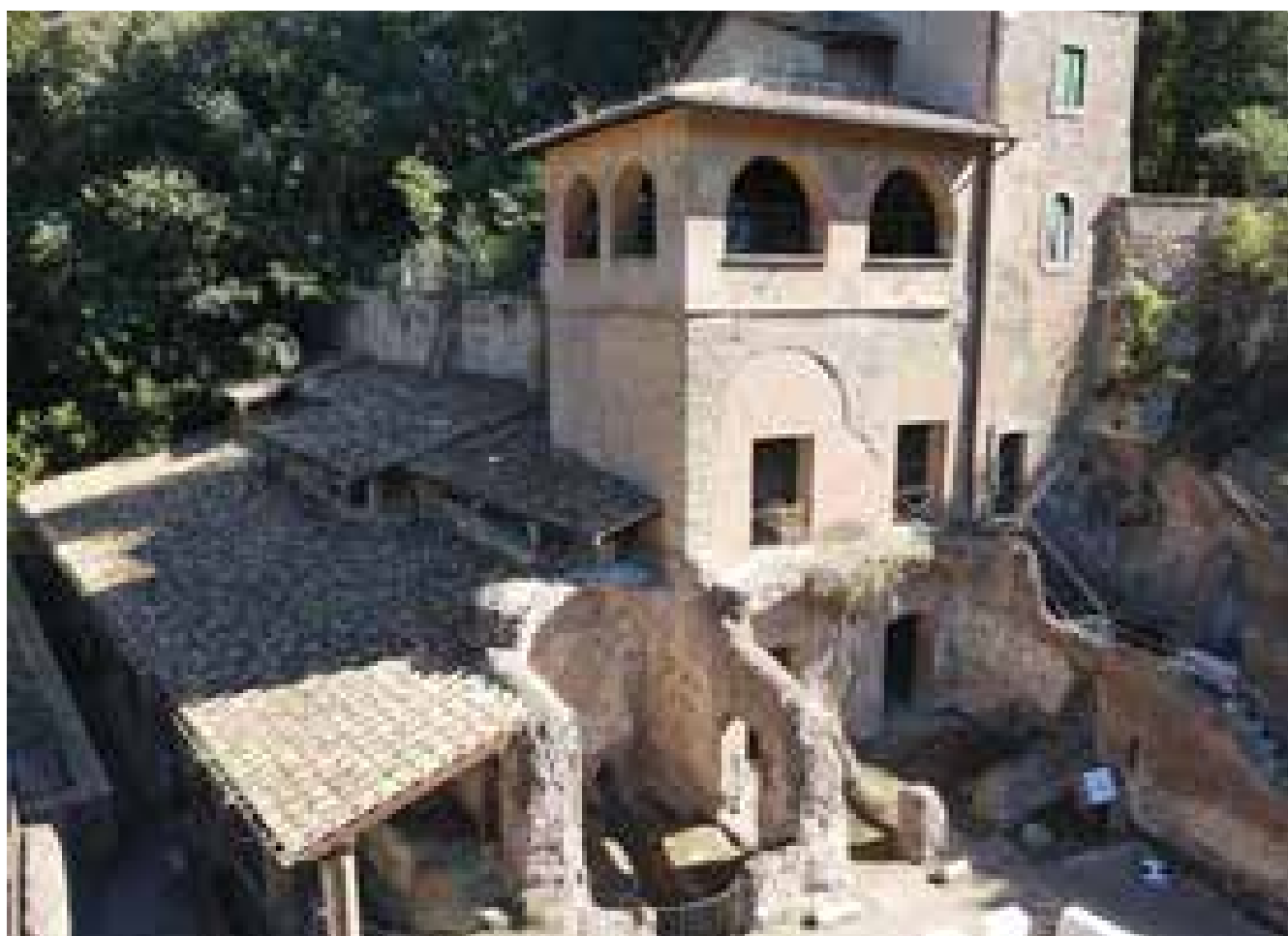
Fig. 152 – Acquisizione con mediante fotogrammetria da drone del complesso del Sepolcro degli Scipioni.
