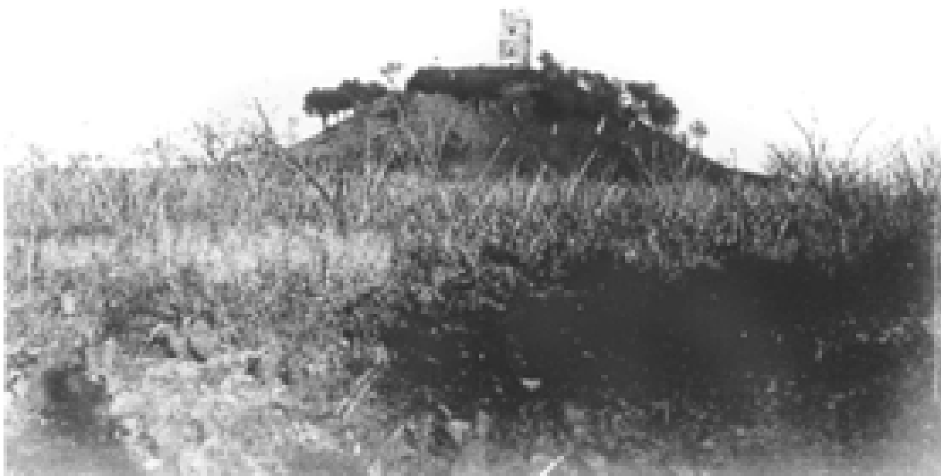
Fig. 130 – Foto del Mausoleo realizzata intorno al 1880.
