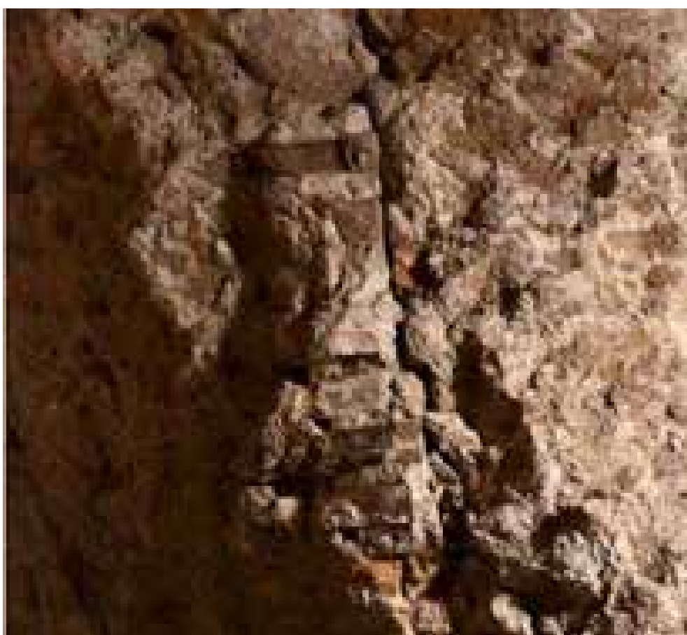
Fig. 165 – Particolare del calcestruzzo romano presente all'interno del Mausoleo di Monte del Grano.
