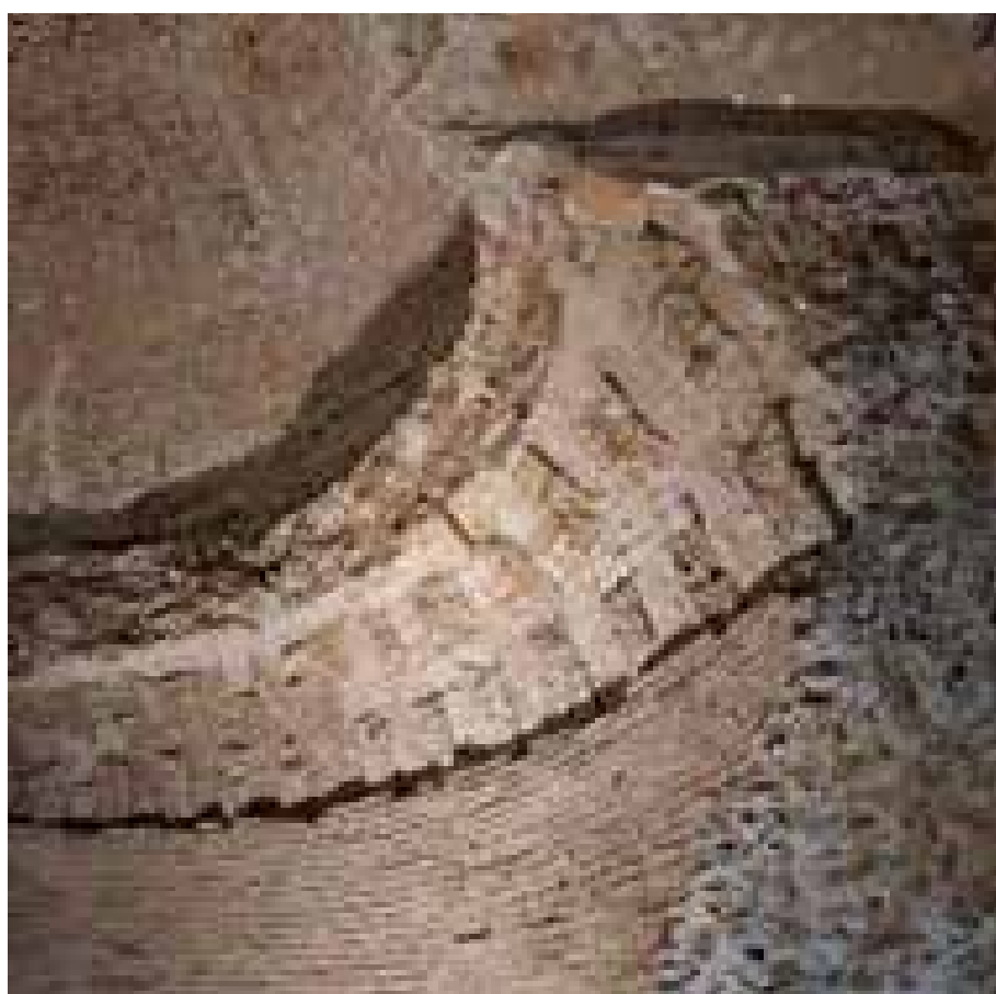
Fig. 163 – Campione di muratura in laterizio, di imposta della volta tra il primo ed il secondo livello, presente all'interno del Mausoleo di Monte del Grano.
