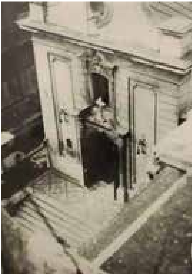
Fig. 46 – Facciata della Cappella di San Rocco dopo l'incendio del 1955.
