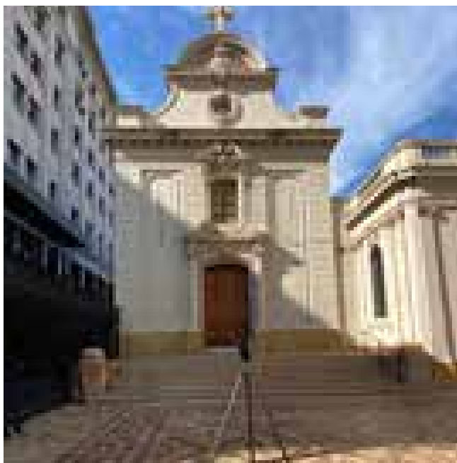
Fig. 56 – Acquisizione con Laser scanner Faro Focus 70 della facciata della Cappella di San Rocco.
