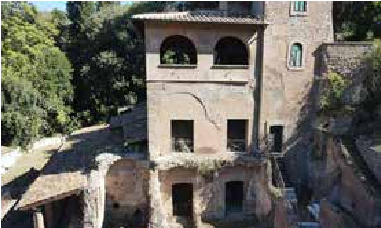
Fig. 162 – Rilievo fotogrammetrico della facciata con uso del drone.
