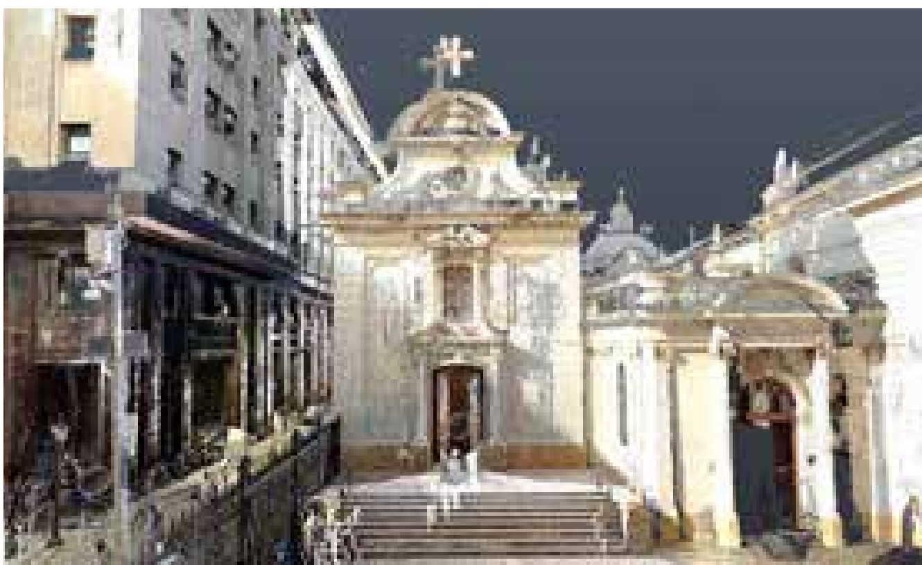
Fig. 67 – Visualizzazione della nuvola di punti integrata tra acquisizione TLS e fotogrammetria da drone.
