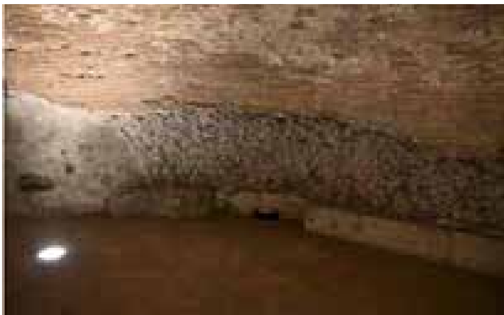
Fig. 164 – Campione di muratura in laterizio, di attacco tra la parete ed il piano del pavimento, presente all'interno del Mausoleo di Monte del Grano.
