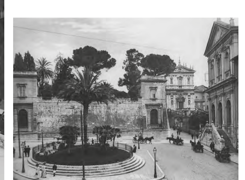
Largo Magnanapoli in un dipinto di Jacopo Fabris del 1761 e in una foto di inizio Novecento con la sistemazione ad aiuola dello spazio centrale con i resti delle Mura Serviane e i due fornicelli di accesso al giardino di Villa Aldobrandini ormai trasformati in finestre per causa dell'abbassamento della quota di imposta del piano urbano.
