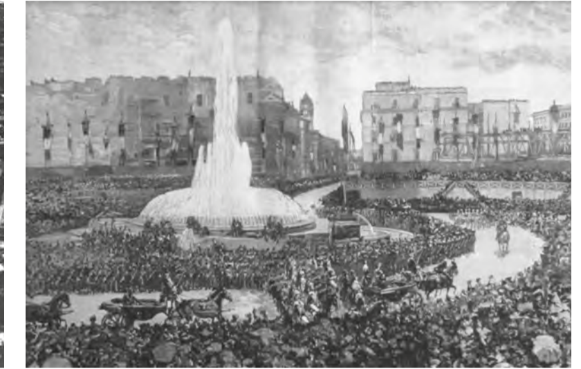
Il grande emiciclo porticato disegnato da Gaetano Koch si imposta sull'esedra dell'antico fabbricato di epoca romana costruendo una quinta edilizia che ingloba gli edifici preesistenti, ancora evidenti in occasione della visita a Roma di Guglielmo II nel 1888.
