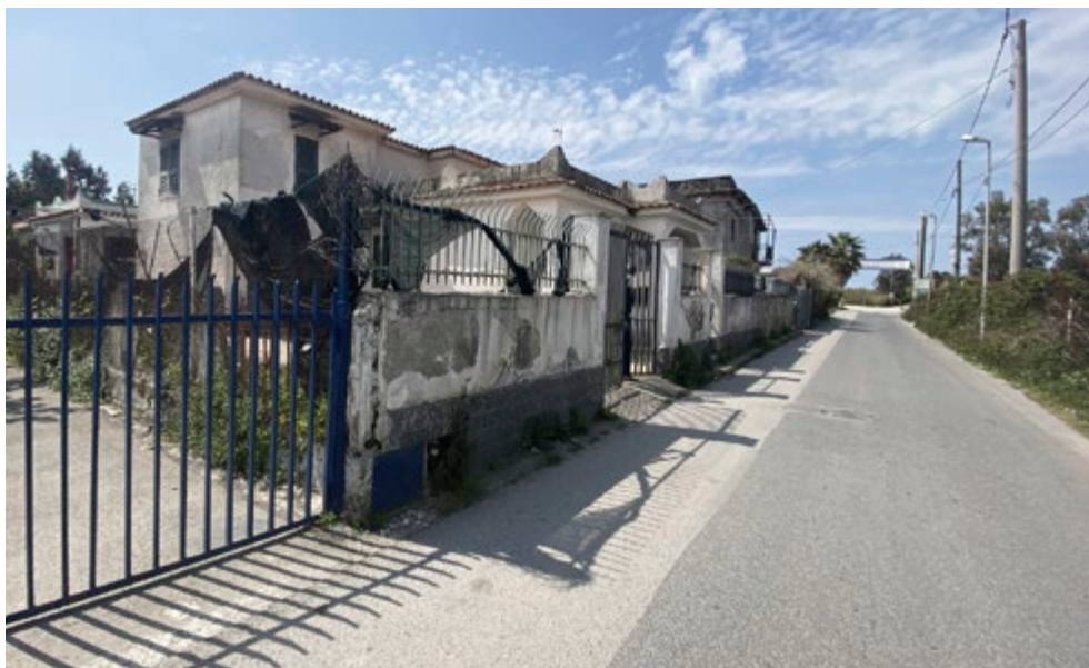
Figura 3. Le villette unifamiliari della 'sacca' di Destra Volturno, dove si concentra parte dell'abitare migrante. Foto delle autrici.
