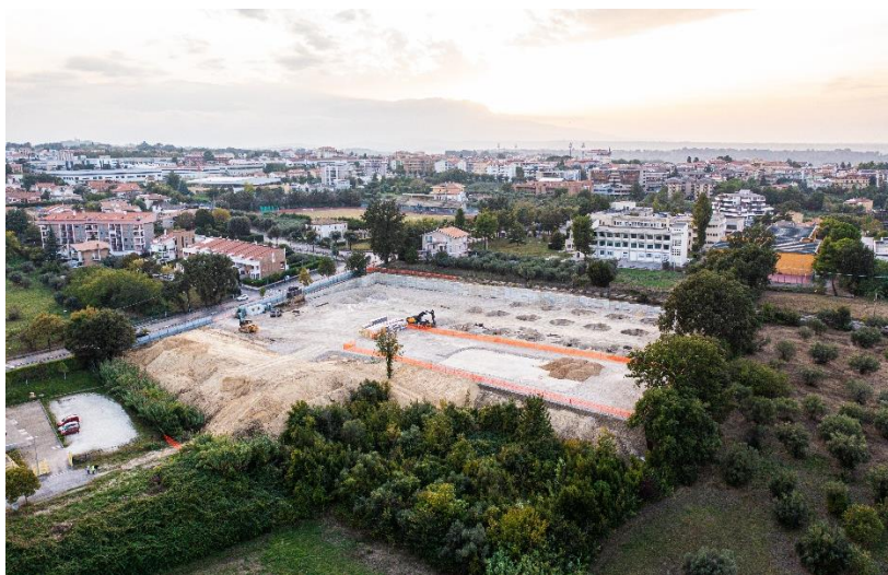
Figura 10. Cantiere per la realizzazione di un'area commerciale nel comune di Lanciano (CH). Foto scattata da Antonello Cimini il 30 ottobre 2023
