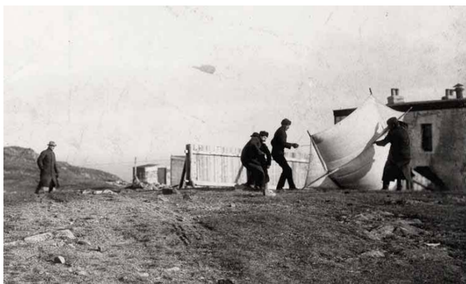
Figura 23: Sollevamento dell'antenna ricevente a San Giovanni di Terranova, 1901.
