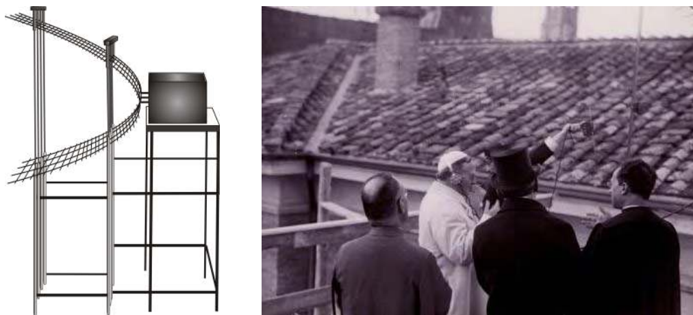
Figura 2: A sinistra: il sistema ad onde ultracorte installato da Marconi a Castel Gandolfo, per il collegamento con Città del Vaticano dopo le prove a Villa Mondragone (elaborazione grafica fatta da Sergio Pandiscia – Università degli studi di Roma Tor Vergata – sulla base di una foto d'epoca) [1]; a destra: Città del Vaticano: il Papa Pio XI prova il radiocollegamento di Marconi con Castel Gandolfo (Marconi è di spalle ed indossa il cappello a cilindro).
