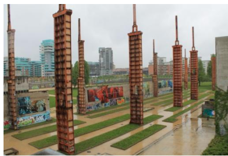
Fig. 16. Capannone di strippaggio B, Lotto Vitali, Parco Dora, Torino.
