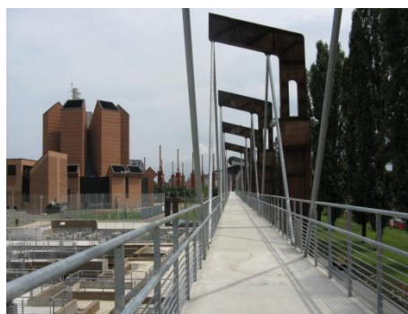
Fig. 13. Passerella, Lotto Ingest, Parco Dora, Torino.
