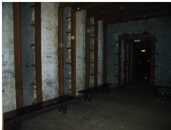
Fig. 57. Interno di una camera di cottura della batteria di forni, Cokeria Zollverein, Essen
