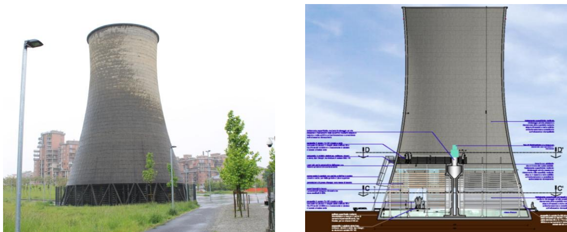
Fig. 20. Torre evaporativa, Lotto Michelin, Parco Dora, Torino: foto dello stato attuale e disegno progettuale (disegno da STS S.p.A.).
