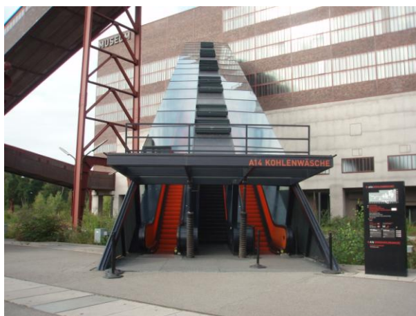
Fig. 55. Scala di accesso all'edificio della Laveria, Zeche Zollverein, Essen
