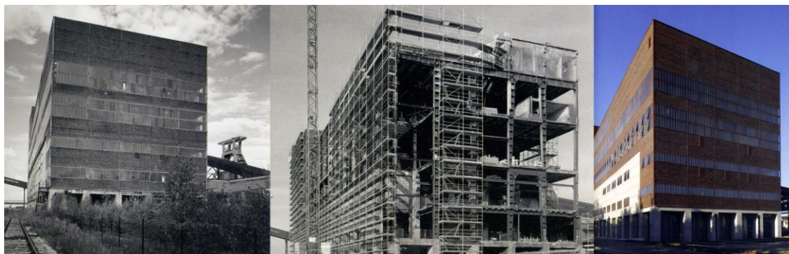
Fig. 68. Rifacimento dell'involucro esterno della laveria prima, durante e dopo l'intervento.
