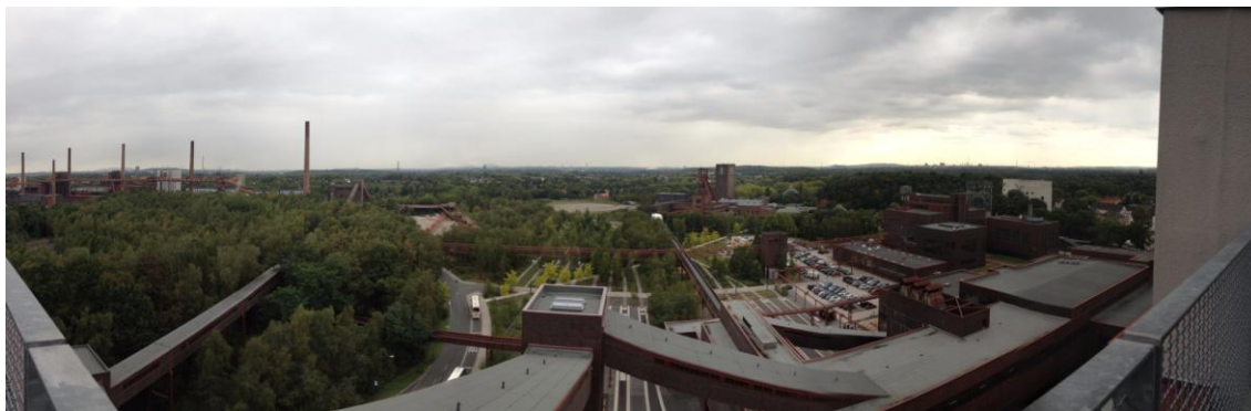
Fig. 53. Foto panoramica dell’intero sito della Zeche Zollverein e della Cokeria Zollverein
