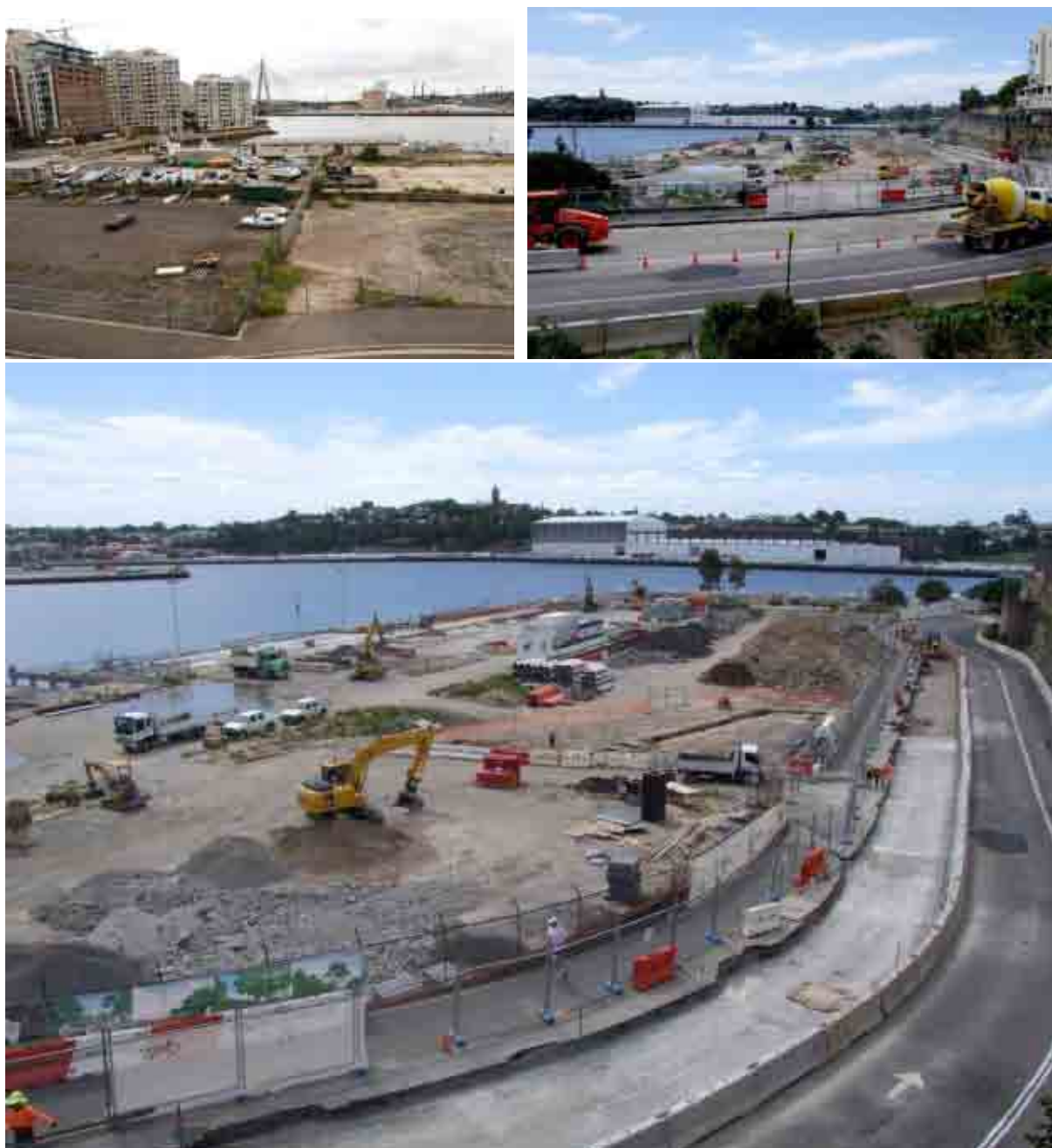
Fig.B5- 2-3-4: Foto dell'area durante la costruzione
