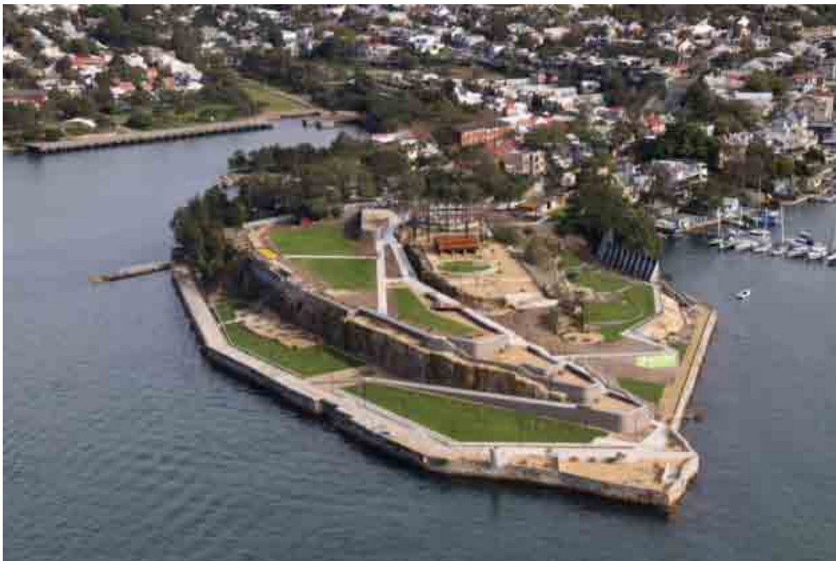
Fig.A5- 4: Vista aerea dell'area
