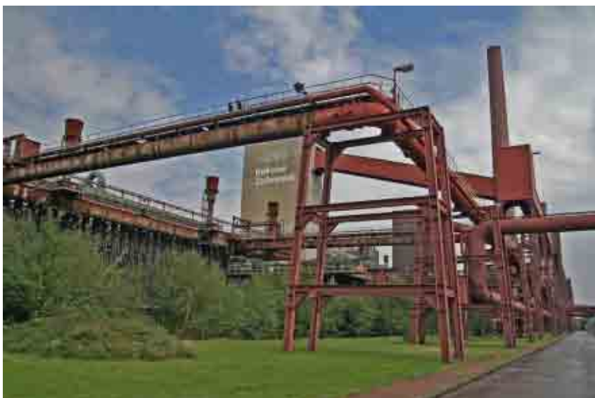
Fig.A3- 6: Foto all'interno dell'area
