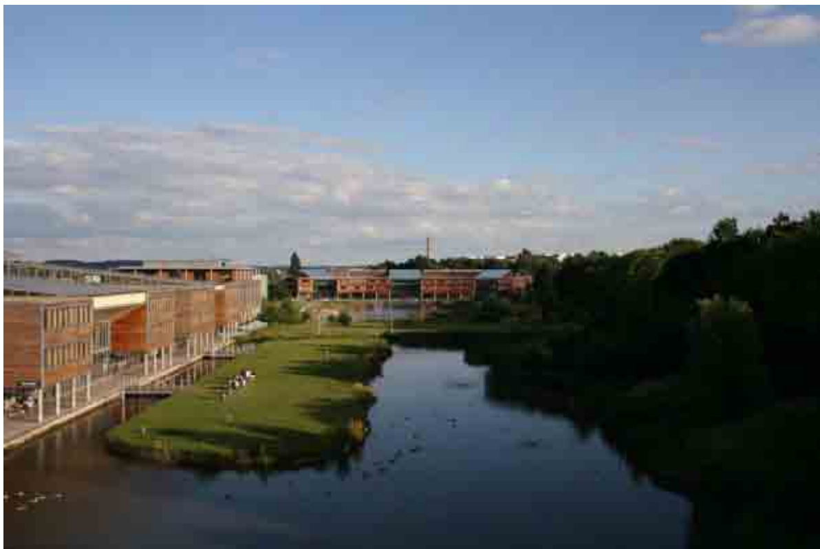
Fig.B1- 4: Foto della nuova sistemazione
