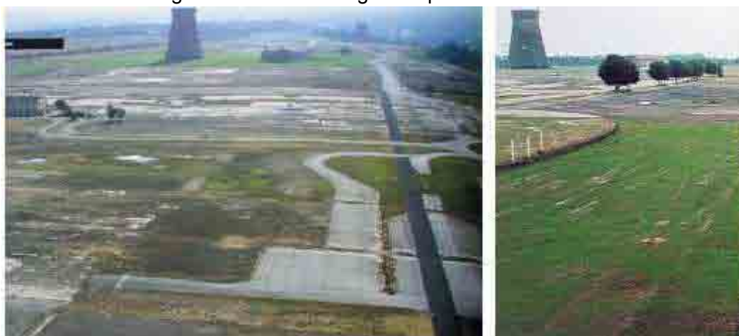
Fig.D1- 2: Veduta dell'area delle acciaierie dopo la demolizione delle strutture industriali
