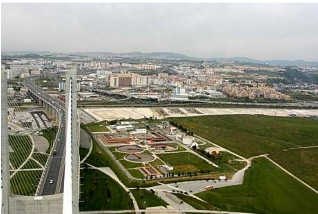
Fig.C3- 3: Vista aerea degli impianti esistenti
