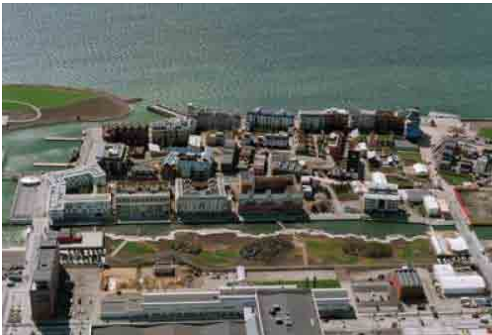
Fig.D3- 2: Foto aerea del cantiere
