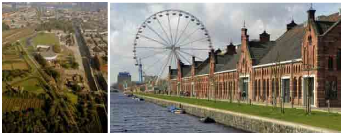
Fig.D6- 4-5: Foto aerea dell'area di intervento, e foto dal ponte
