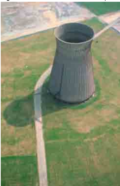
Fig.D1- 6: Veduta della torre con le prime sistemazioni a verde.
