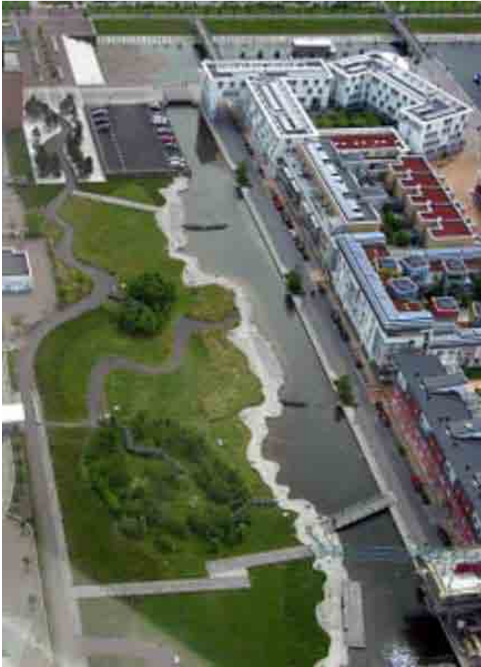
Fig.D3- 4: Foto dell'area a lavori quasi ultimati
