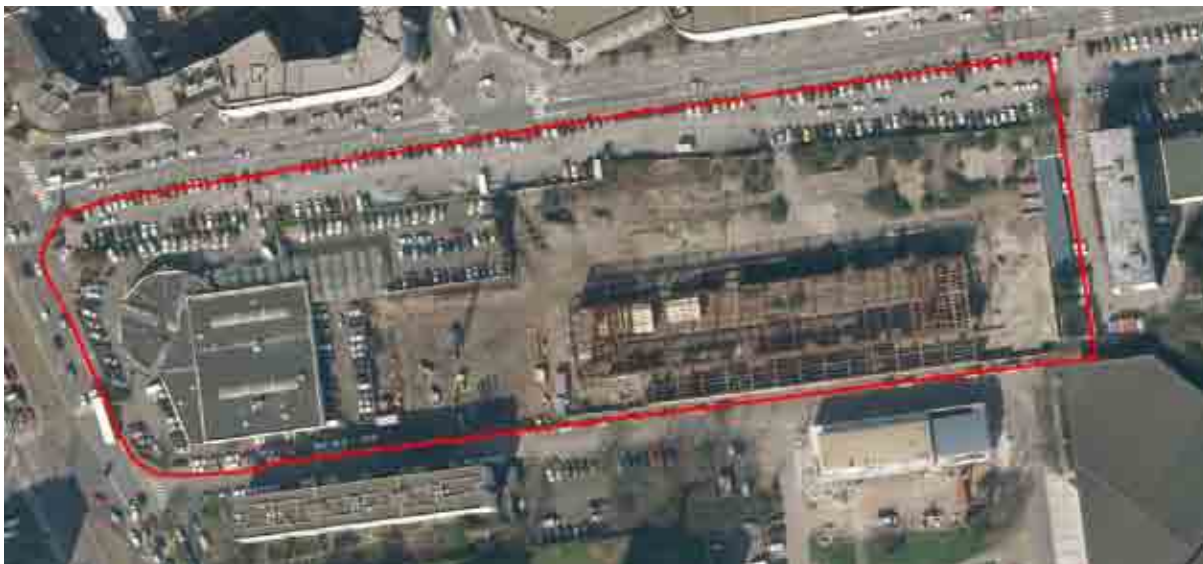
Fig.B6- 2: Foto satellitare dell'area durante i lavori di demolizione dell'impianto industriale
