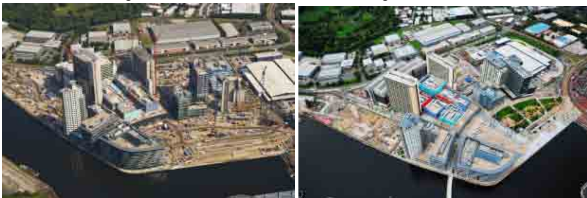
Fig.D4- 8-9: Foto aeree in due fasi diverse di avanzamento dei lavori
