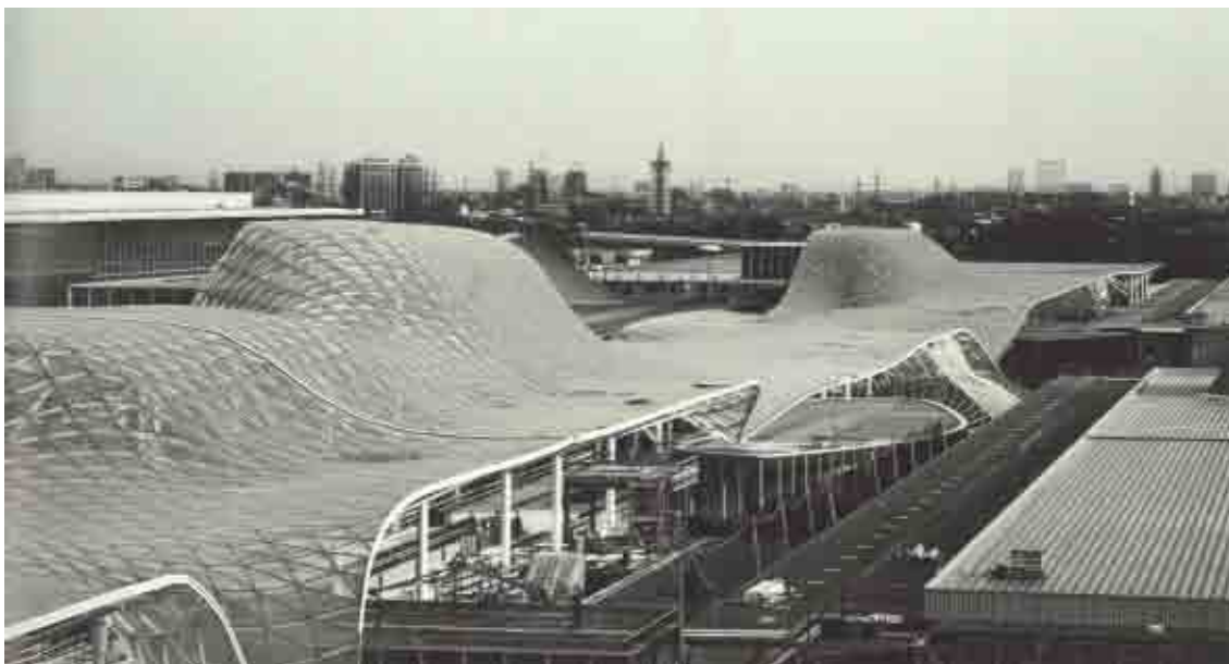
Fig.C2- 11: Veduta della “Vela”, la struttura in vetro divenuta simbolo della nuova fiera di Milano 92
