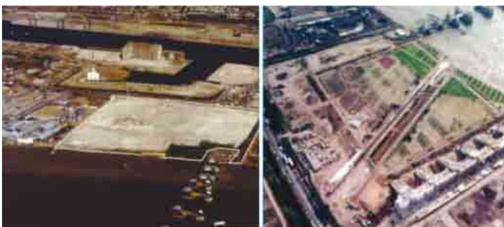
Fig.B7- 5-6: Foto aeree prima dell’intervento e durante i lavori
