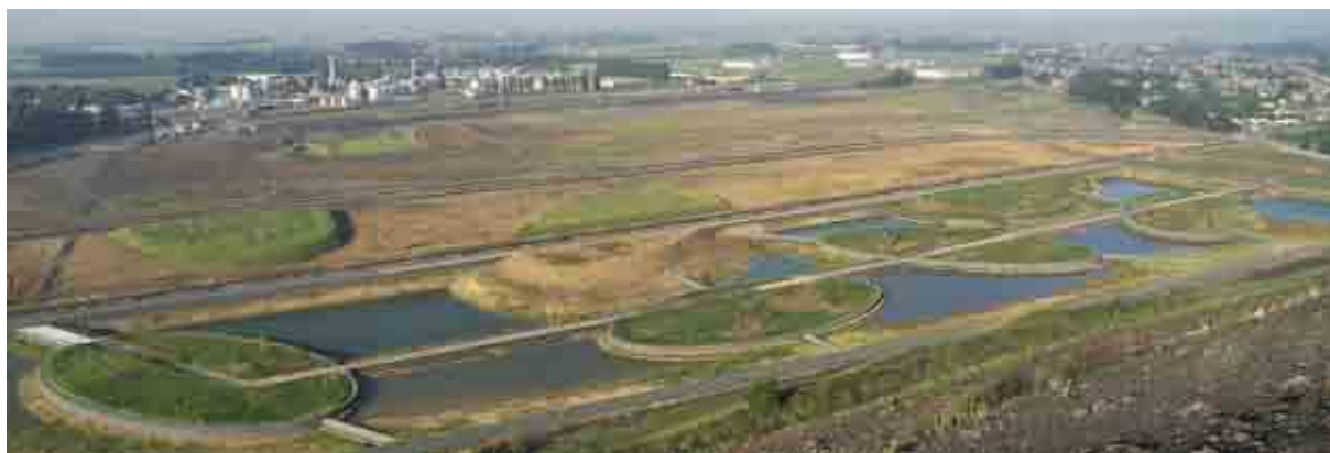
Fig.D5- 6: Foto Aerea dell'area di progetto durante il cantiere
