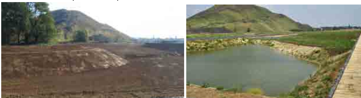
Fig.D5- 3-4: Foto durante le opere di sbancamento e modellazione del terreno, e foto con le vasche riempite d'acqua
