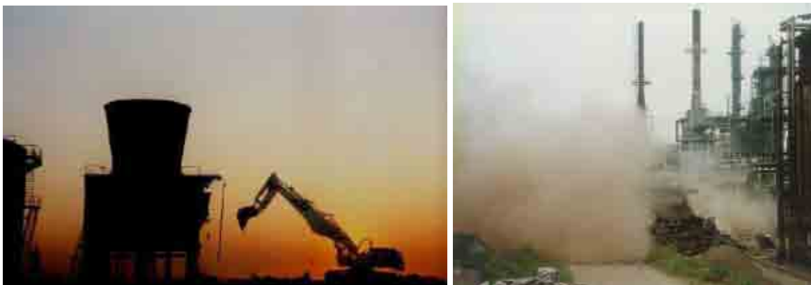
Fig.C2- 3: Fasi della demolizioni della raffineria
