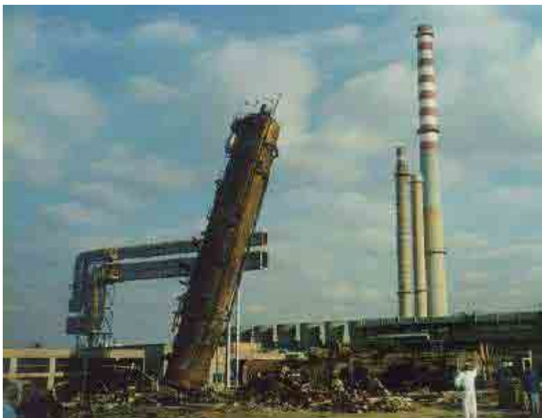
Fig.C2- 4: Fasi della demolizioni della raffineria
