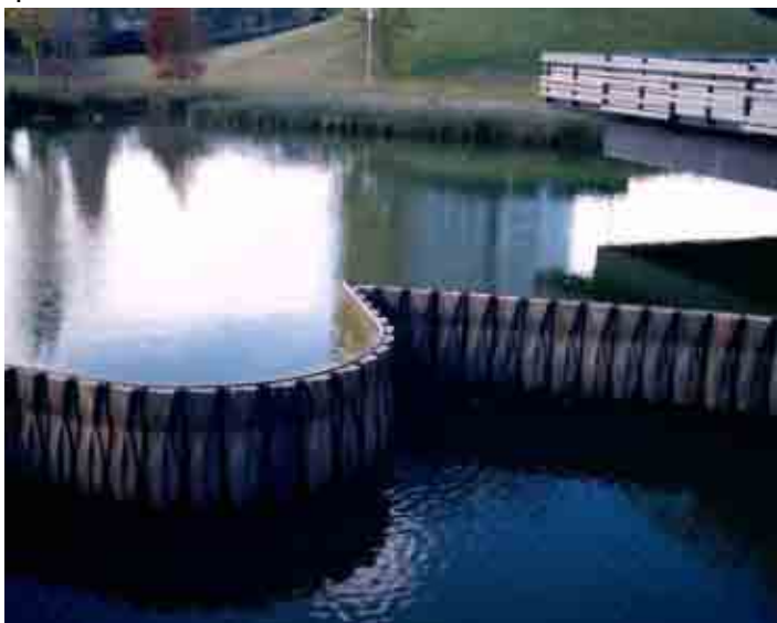
Fig.B2- 13: Foto del parco – diga e depurazione delle acque
