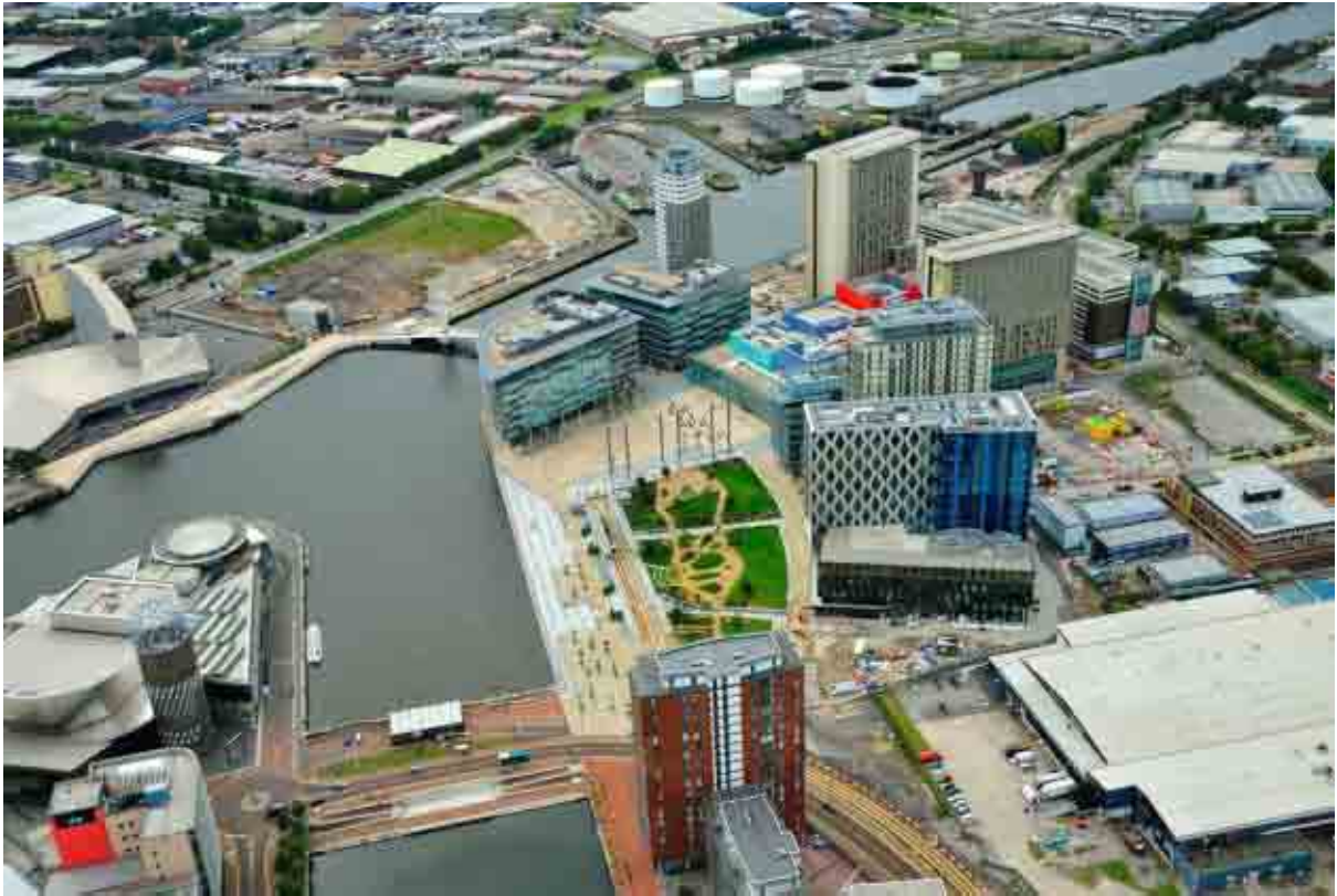
Fig.D4- 14: Foto aerea dell'area con il nuovo ponte che collega le due sponde del fiume
