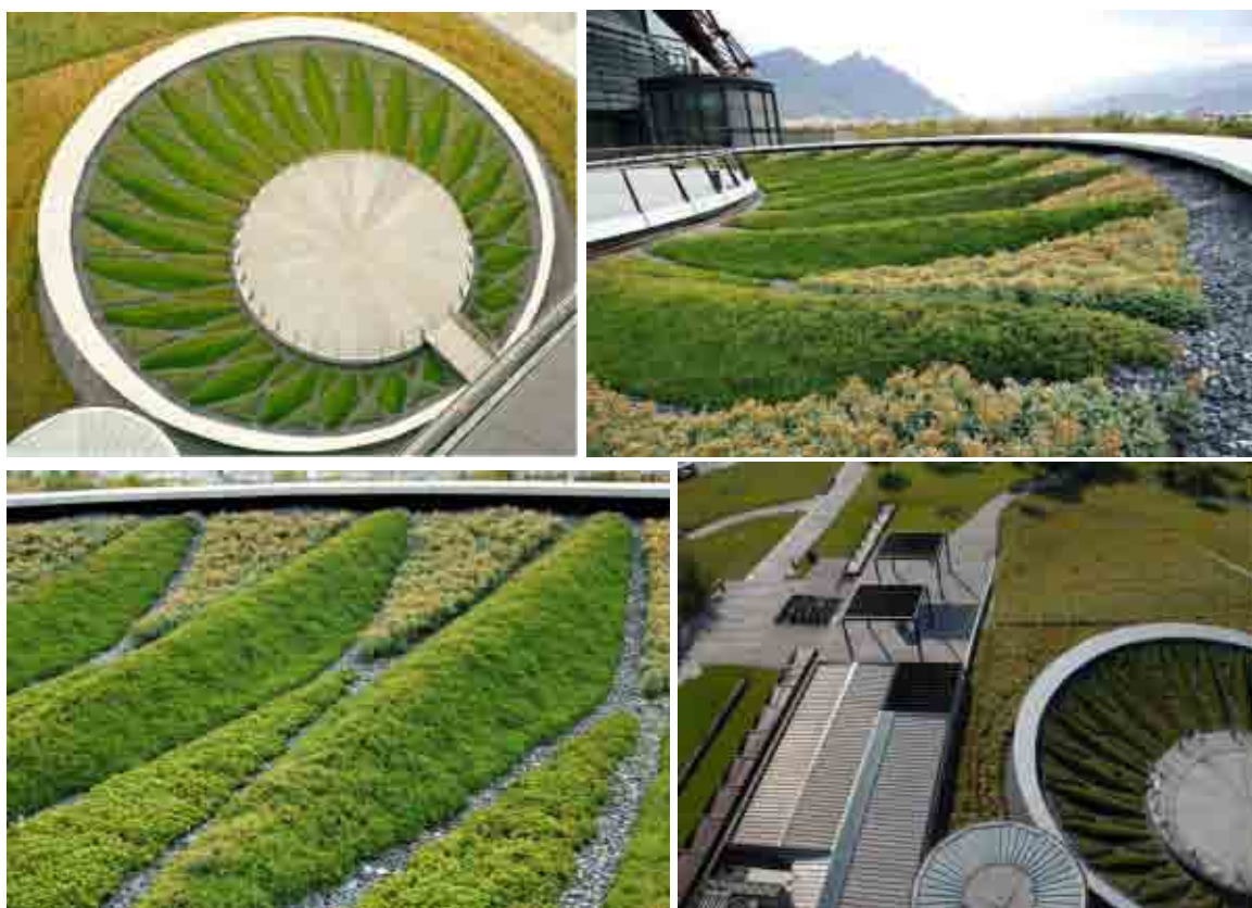
Fig.A4- 6-7-8-9: Foto della coperture della sala di esposizione del museo
