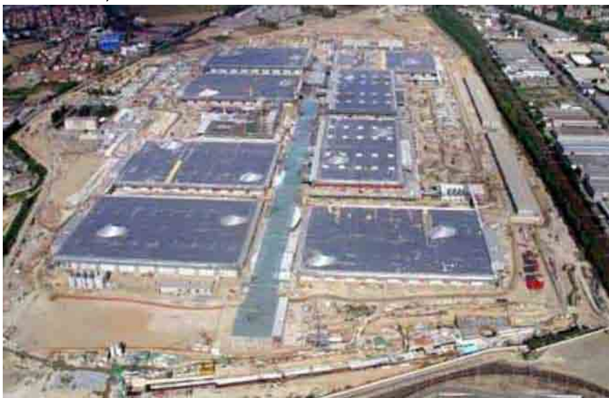
Fig.C2- 8: Foto aerea dell'avanzamento del cantiere
