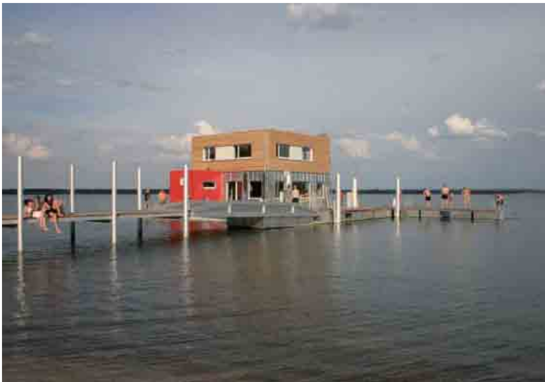
Fig.B4- 11: Scuola di tuffi galleggiante sulla Gräbendorfer See
