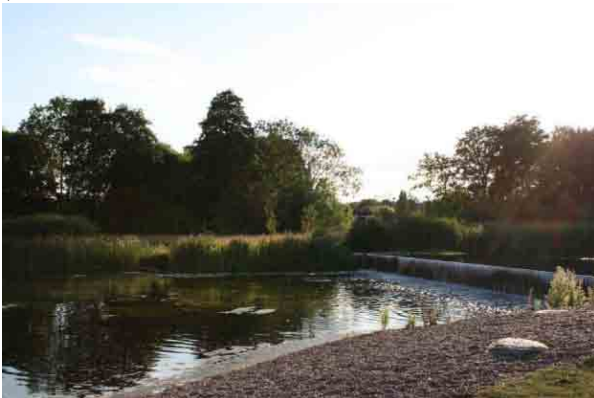
Fig.B1- 7: Foto della rigenerazione delle acque
