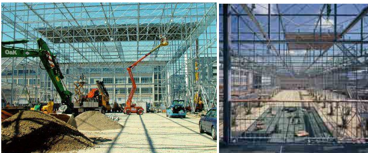
Fig.C6- 11-12 : Foto di cantiere
