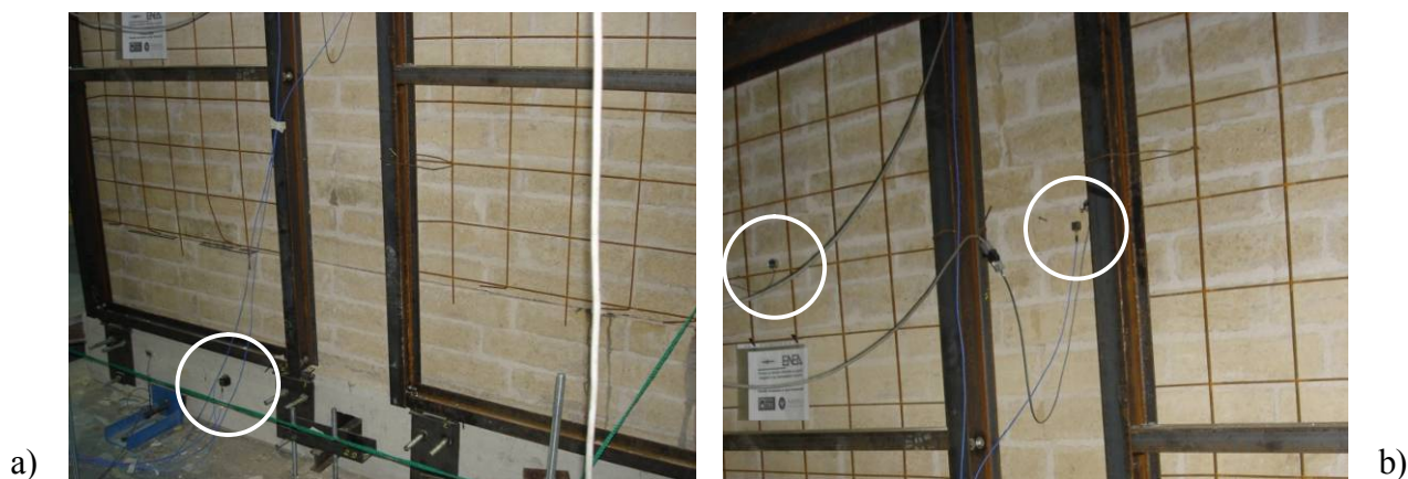
Figura C- 21. Accelerometri DiS su: a) cordolo; b) facciata.
