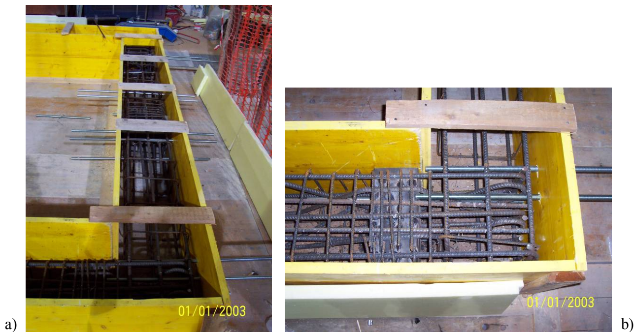
Figura C- 2. Dettaglio armatura cordolo di fondazione.
