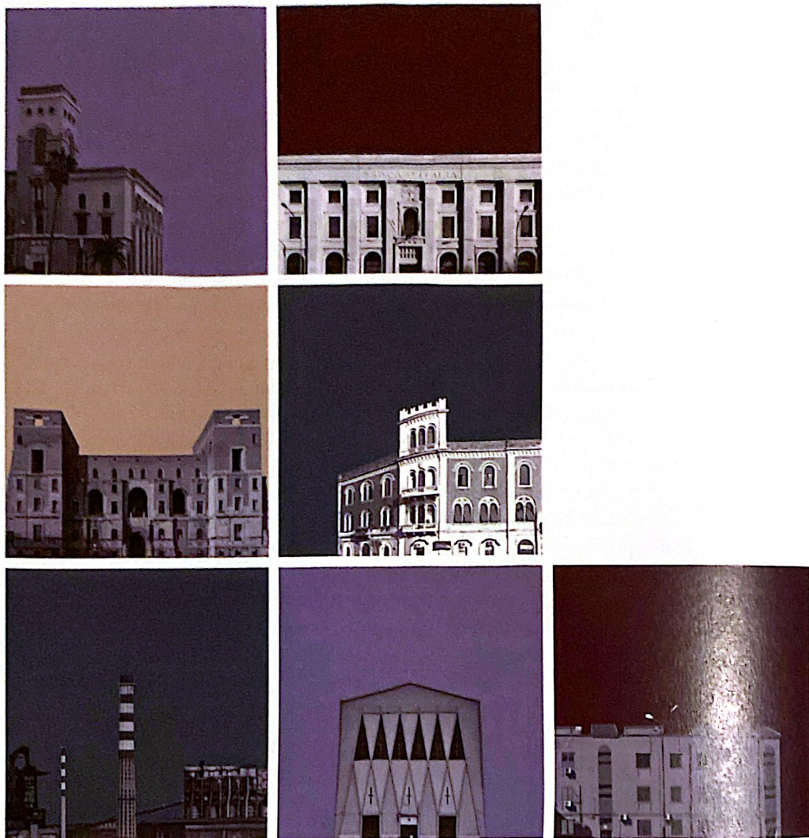
Fig. 4. Manuela Ciangola, Francesco Masiello. Januis waterfronts (from left, top) Palazzo delle Poste e dei Telegrafi, Banco d'Italia, Palazzo del Governo, Palazzo Magnini, ILVA's towers, church of Gesù Divin Lavoratore, INA-CASA model building, Roma, 2025
