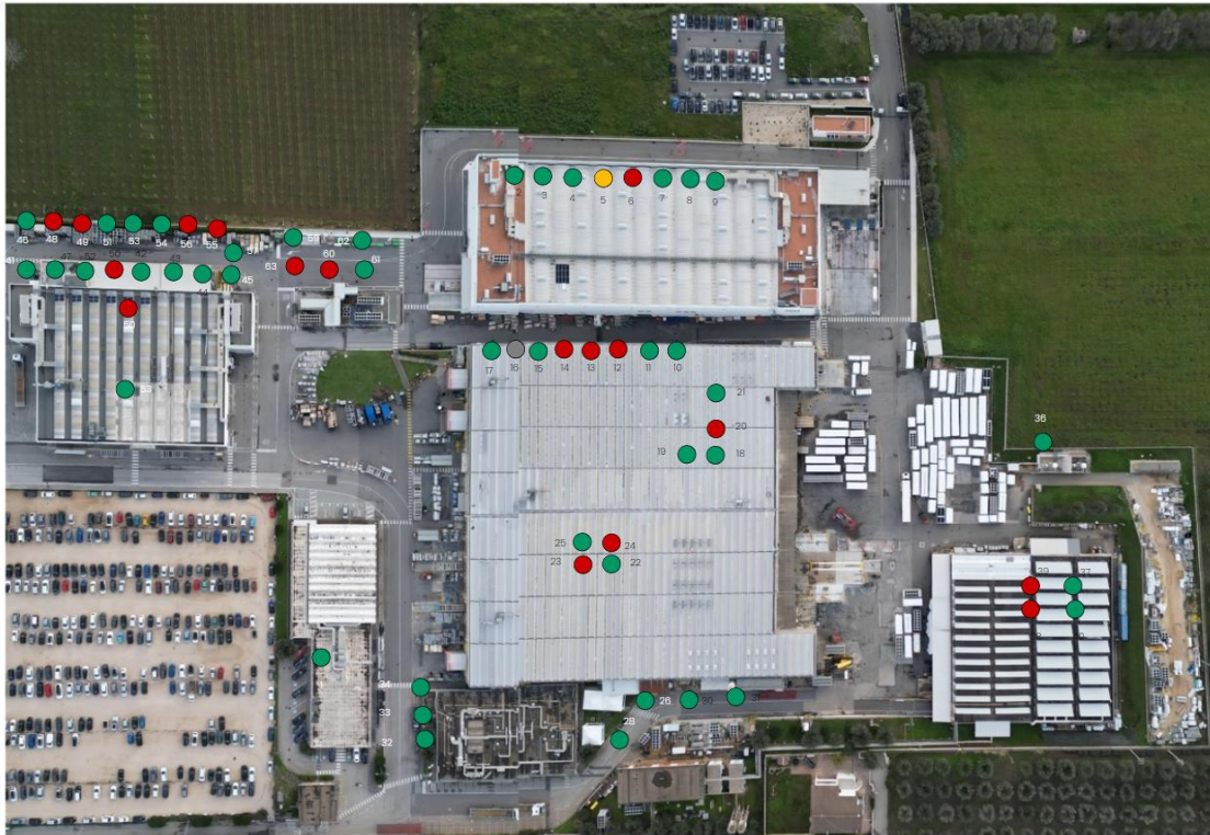
Figura 45 posizionamento dei multimetri nell'impianto
