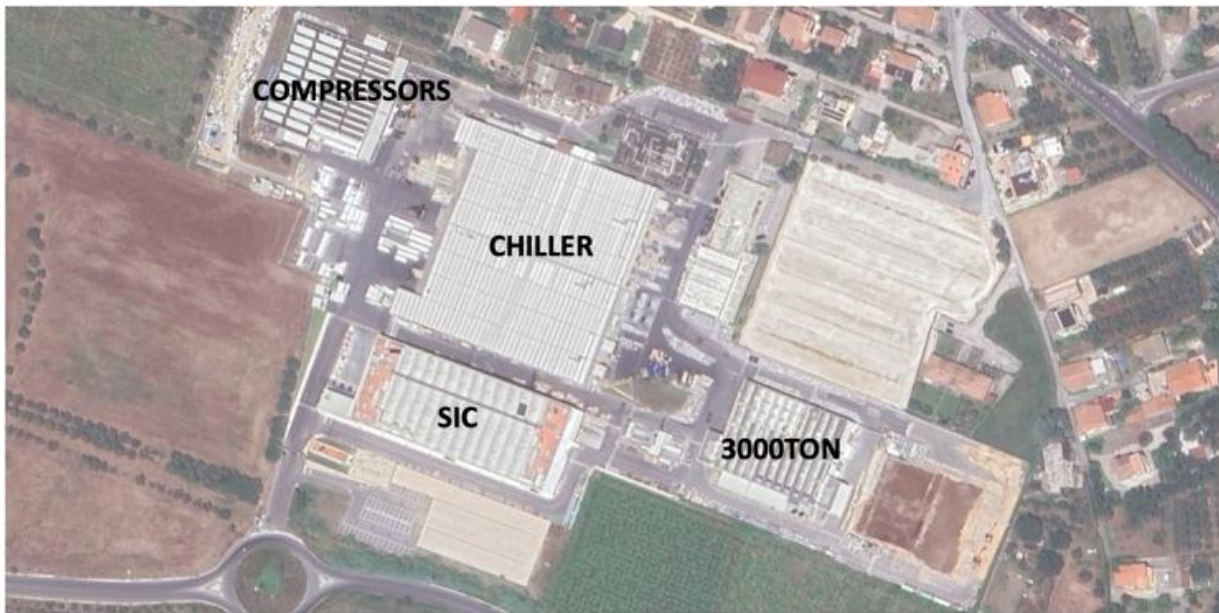
Figura 42 impianto di produzione. Vista dall'alto
