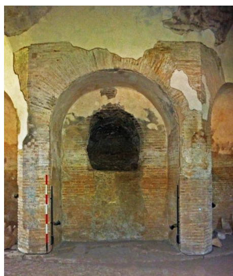
Figg. III.66 – III.67: Mausoleo c.d. di Romolo. Nicchie che scandiscono il pilastro centrale. A destra è visibile la breccia effettuata all'interno della nicchia (Foto R. Santarelli 2022).
