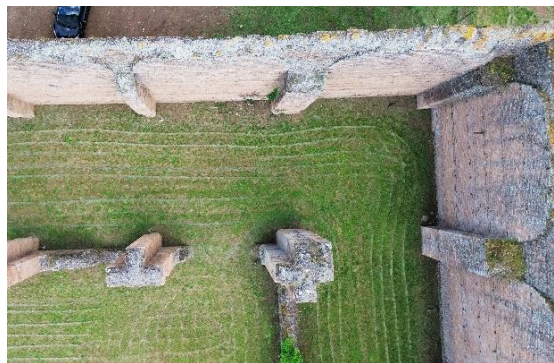
Fig. III.15: Angolo est. Vista dall'alto del quadriportico. Come si può evidenziare dall'immagine, il muro perimetrale risulta essere molto sottile (Foto R. Santarelli 2024).
