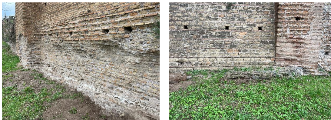
Figg. III.45 – III.46: Fondazioni. A sinistra i resti del piano in bipedali presso l'angolo occidentale. A destra i resti delle fondazioni, con salto di quota, presso il doppio pilastro dell'ambiente settentrionale (Foto R. Santarelli 2024).
