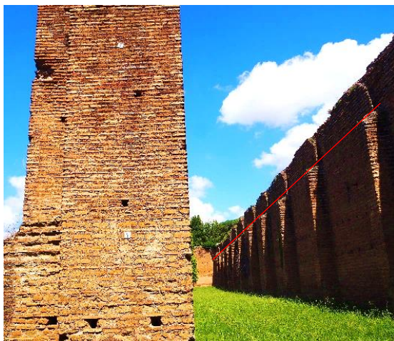
Fig. III.14: Lato nord-est. Pilastrì a sezione quadrata che scandiscono il muro del perimetro esterno. Si mette in evidenza in questa immagine come i pilastrì si siano conservati tutti fino all'altezza dell'imposta inclinata (Foto R. Santarelli 2025).
