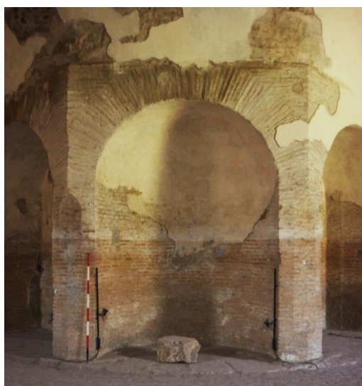
Figg. III.66 – III.67: Mausoleo c.d. di Romolo. Nicchie che scandiscono il pilastro centrale. A destra è visibile la breccia effettuata all'interno della nicchia (Foto R. Santarelli 2022).
