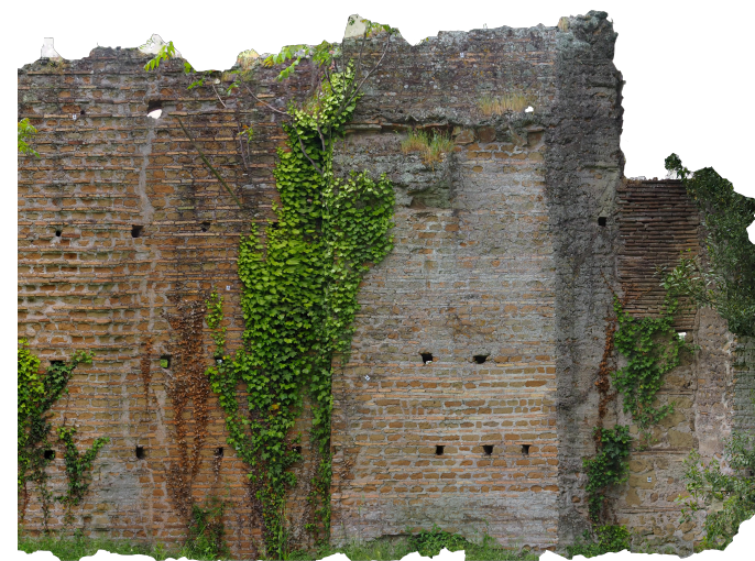
Dettaglio prospetto terme, angolo nord
