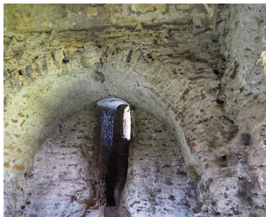
Figg. III.27 – III.28: Sepolcro c.d. dei Servili. A sinistra, due delle tre nicchie interne del sepolcro. La nicchia sud-est è stata chiusa successivamente da un muretto. A destra, particolare della finestra a bocca di lupo che si apre nel lato sud-orientale (Foto R. Santarelli 2025).
