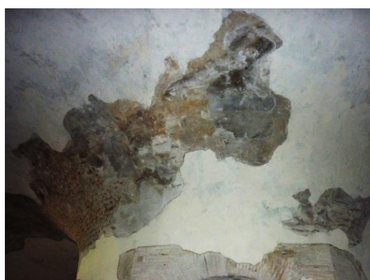
Fig. III.69: Mausoleo c.d. di Romolo. Intonaco che ricopre la volta a botte anulare interna al mausoleo (Foto R. Santarelli 2022).
