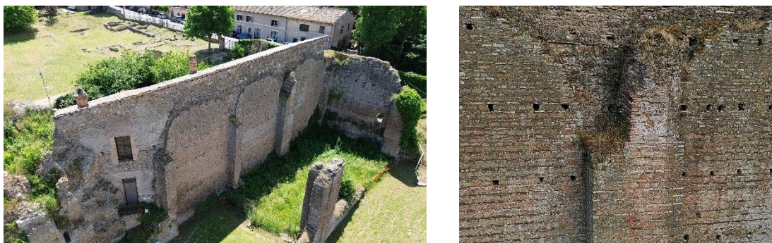
Fig. III.23 a-b: Quadriportico. A sinistra, vista dall'alto delle tre campate meridionali. A destra, particolare del pennacchio della volta che copriva l'ambiente dell'angolo sud (Foto R. Santarelli 2025).
