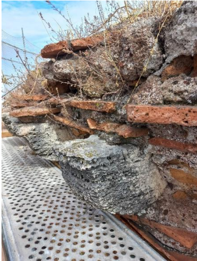
Fig. IV.9: Il mausoleo di Tor de' Schiavi. Dettaglio delle mensole che coronano il corpo cilindrico. Foto effettuata durante i lavori di restauro (Foto di R. Santarelli).
