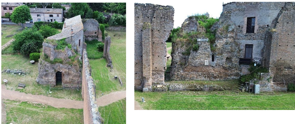
Figg. III.24 – III.25: Sepolcro c.d. dei Servii. A sinistra una visuale dall'alto del lato nord-est; a destra, il prospetto nord-occidentale dove si possono apprezzare i resti dei blocchi di travertino che ricoprivano la struttura (Foto R. Santarelli 2025).
