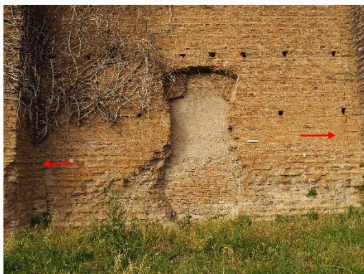
Fig. III.32 a-b: Apertura nel lato nord-orientale. A sinistra si vedono le cuciture del passaggio di cantiere; a destra come queste cuciture arrivino fino all'imposta della volta. (Foto R. Santarelli 2025).
