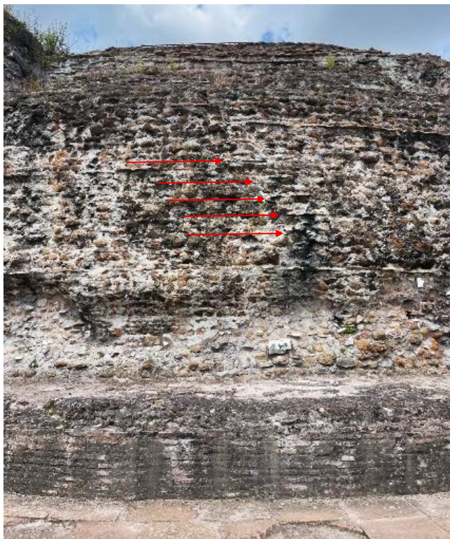
Fig. III.53: Mausoleo c.d. di Romolo. Indicati con le frecce i ricorsi di bipedali sfalsati in modo segmentato. (Foto R. Santarelli 2025).
