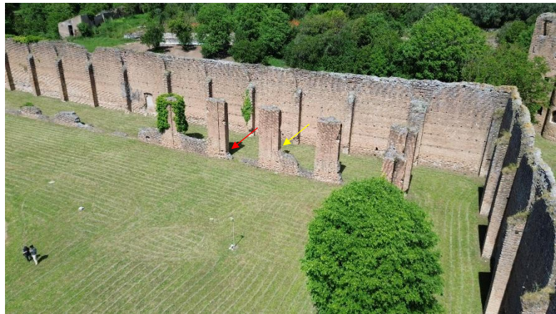
Fig. III.44: Lato nord-orientale; sono visibili le imposte della porta (freccia rossa) e della finestra (freccia gialla) (Foto R. Santarelli 2024).
