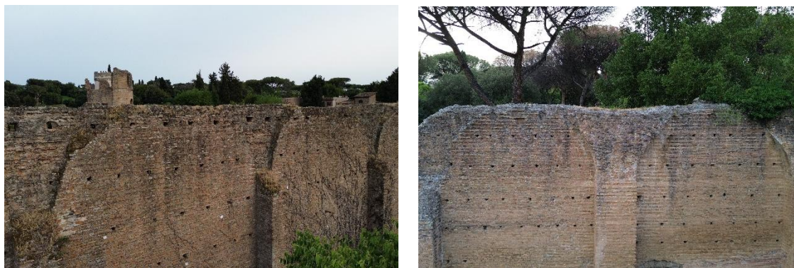
Figg. III.47 a-b: Centine delle volte. A sinistra l'incavo di appoggio delle centine, a destra si evidenziano i grandi fori che dovevano servire per il fissaggio dell'asse centrale della centina (Foto R. Santarelli 2024).
