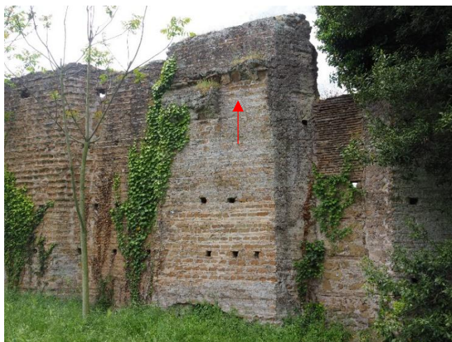
Fig. III.39: Resti delle terme. Articolazione dell'angolo settentrionale del c.d. Quadriportico a causa della preesistenza delle terme. Si vedono i resti dell'abside del calidarium (Foto R. Santarelli 2025).
