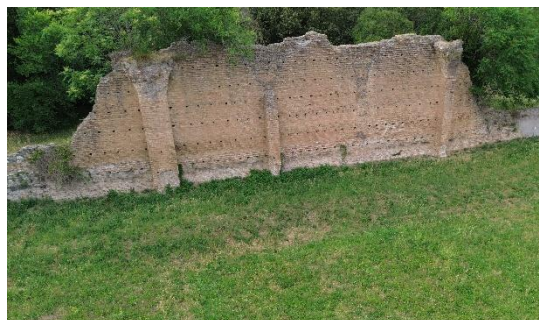
Figg. III.34 – III.35: Lato sud-occidentale del c.d. Quadriportico. A sinistra l'angolo settentrionale in cui sono visibili i resti dei pennacchi ancora in situ , la porta e il piano in bipedali che copriva la fondazione; a destra invece i resti dei pennacchi presso l'angolo ovest e la lacuna che contraddistingue la parte inferiore di tutti i lati del portico (Foto R. Santarelli 2025).
