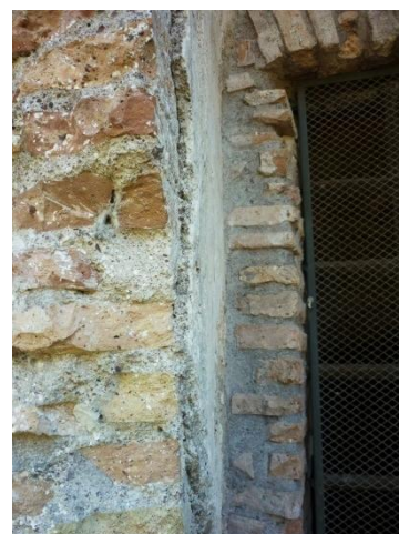
Fig. III.68: Mausoleo c.d. di Romolo. Intonaco originale all'interno della finestra (Foto R. Santarelli 2022).
