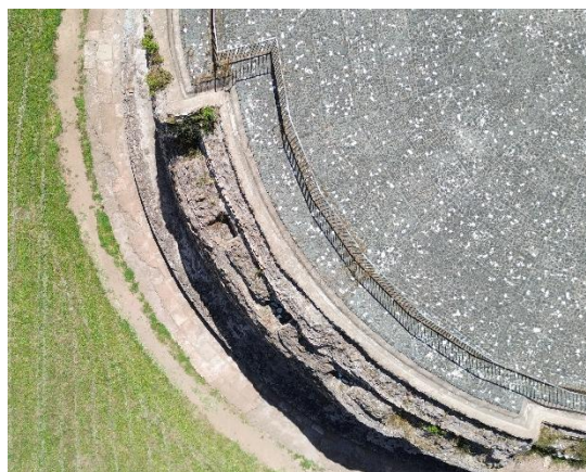
Fig. III. 54: Mausoleo c.d. di Romolo. Tracce degli incassi per le mensole che dividevano il primo dal secondo piano della struttura (Foto R. Santarelli 2025).
