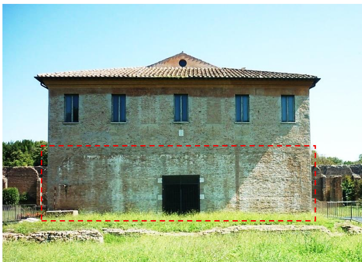
Fig. III.58: Mausoleo c.d. di Romolo. Prospetto sud-occidentale con particolare evidenza della parete di fondo delle scale di accesso al pronao (Foto R. Santarelli 2025).
