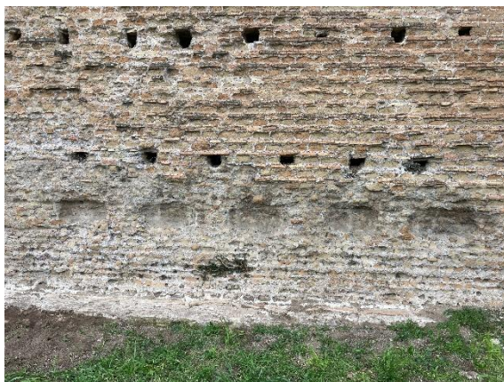
Figg. III.37 – III.38: A sinistra, le lacune puntuali visibili sul lato occidentale; a destra, le medesime lacune rilevate sul lato settentrionale, dove, in modo anomalo, i fori da ponte mostrano una variazione nella loro regolarità (Foto R. Santarelli 2025).
