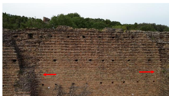
Fig. III.32 a-b: Apertura nel lato nord-orientale. A sinistra si vedono le cuciture del passaggio di cantiere; a destra come queste cuciture arrivino fino all'imposta della volta. (Foto R. Santarelli 2025).
