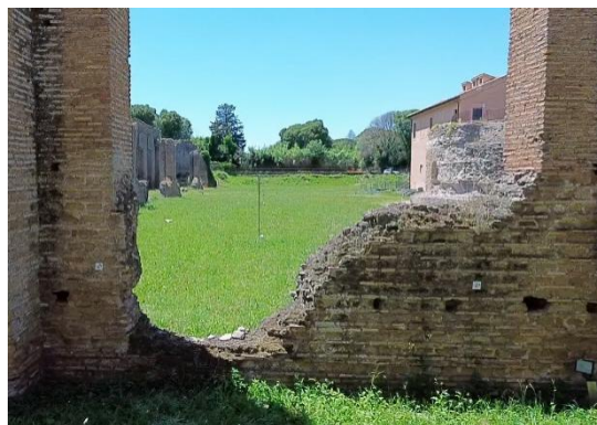
Figg. III.16 – III.17: A sinistra, il nucleo cementizio stratificato, costituito prevalentemente da frammenti di tufo e laterizio, legati da una malta ricca di pozzolana; a destra, una porzione dei resti del perimetro interno nord-orientale, dove si distinguono sia il piano d’imposta di una finestra sia la variazione dell’opera vittata in opus testaceum per la parte superiore dei pilastri (Foto R. Santarelli 2024).
