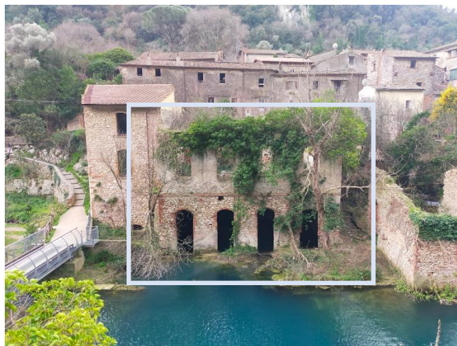
Figura 87. Stato attuale della storica centrale “Aldobrando Netti”
