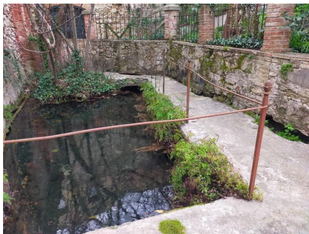
Figura 91. Dettaglio della vasca di carico esistente in prossimità dell'ingresso della storica centrale
