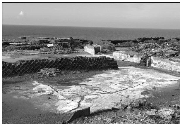
Fig. 2 Pandataria, Villa di Giulia. Vestibolo (Tav. 54, n. 4). Si notino i muri di fondo in blocchi di tufo e i tramezzi ortogonali in opera reticolata. Il tutto era rivestito di intonaco policromo (foto dell'Autore).
