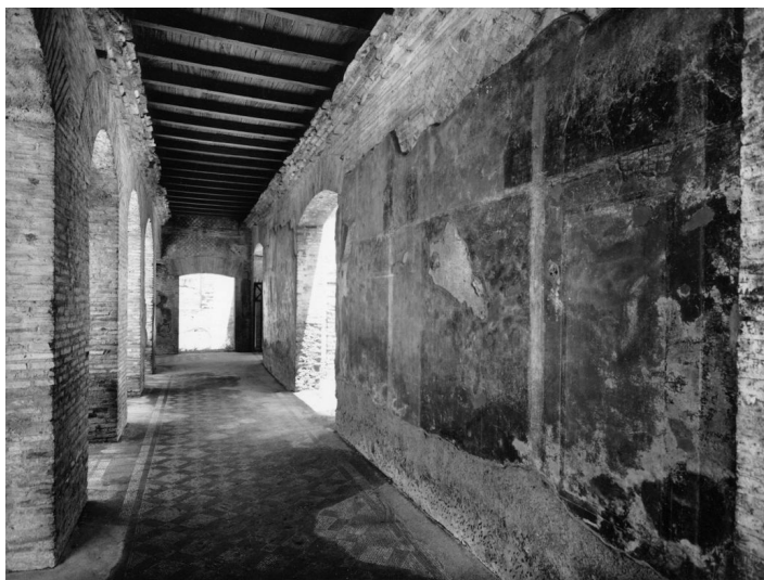
Fig. 2. Domus delle Muse, la copertura in cemento armato dipinta a finto legno (ICCD, inv. E40649).
