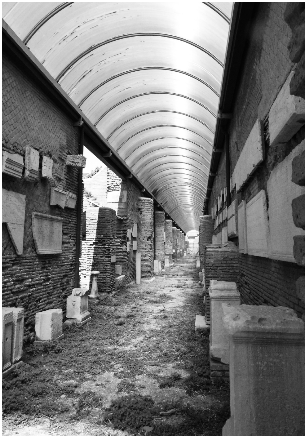
Fig. 5. Galleria Lapidaria, copertura in acciaio e policarbonato.
