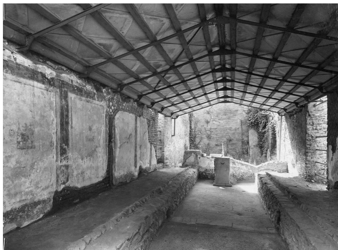
Fig. 3. Mitreo del Menandro, la copertura in etemit (ICCD, inv. E40920).
