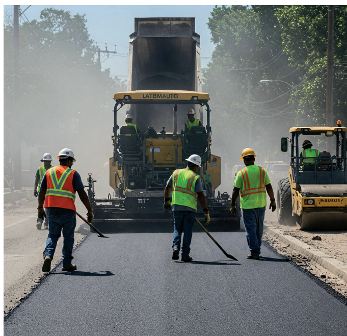
1. La sostenibilità ambientale degli appalti stradali è al centro dei CAM
