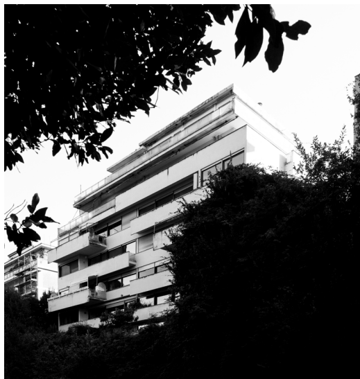
Palazzina Domus, Roma, Via di San Crescenziano, (1950-52). Scorcio del prospetto su Via Salaria.
