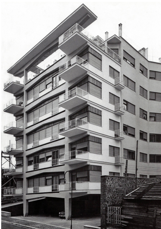
Palazzina Cassiopea, Roma, Via Archimede (1949-50). Veduta del fronte su strada. Foto d'epoca.
