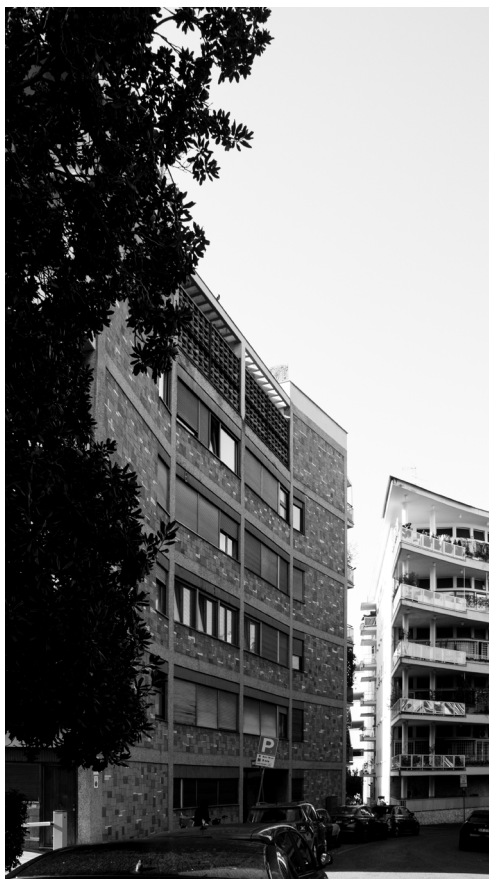
Palazzina Giammarusti, Roma, Via Elli Ruspoli angolo Largo Messico (1953-54). Veduta del fronte su Via Elli Ruspoli. Sullo sfondo si nota la palazzina "La nave" progettata da U. Luccichenti.
