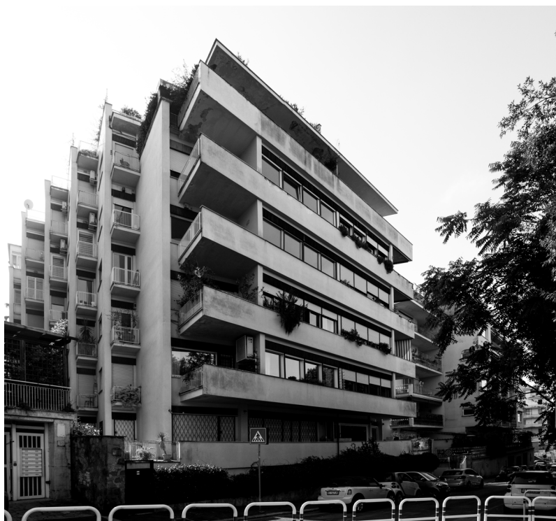
Palazzina Palladium, Roma, Via Archimede (1951). Veduta del fronte stradale.
