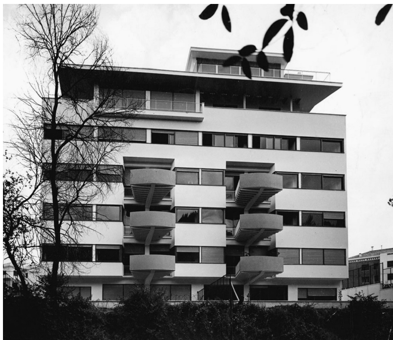
Palazzina Federici, Roma, Via di San Crescenziano (1950-52). Veduta del fronte su Via Salaria. Foto d'epoca.
