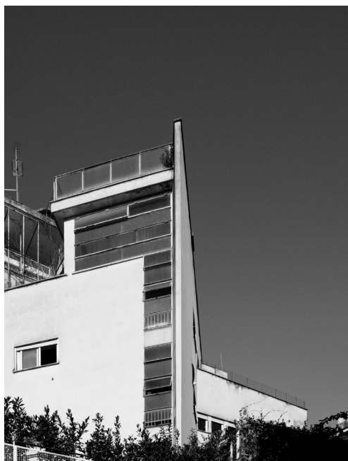
Palazzina Domus e Federici, foto di dettaglio delle due soluzioni di corpi scale.
