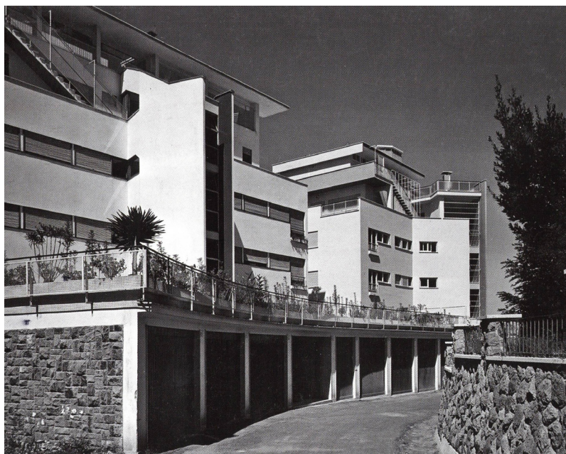
Palazzine Federici (sx) e Domus (dx), Roma, Via di San Crescenziano (1950-52). Veduta d'insieme dei fronti su Via di San Crescenziano in cui appaiono i differenti trattamenti dei corpi scala e dei prospetti. Foto d'epoca
