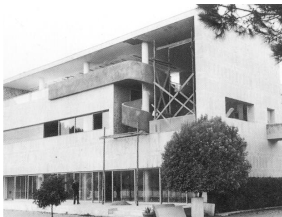
Villa Petacci, Roma, (1938-39). Veduta del fronte princi- pale durante il cantiere. Foto d'epoca
