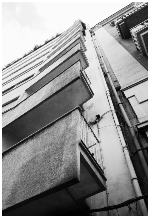
Edificio d'angolo, articolare del sistema di giun- zione tra i balconi e la cortina edili- zia su Via Regina Margherita
