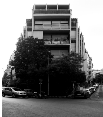
Palazzina Antares, vedute dei fronti nell'angolo tra Via di San Valentino e Via A. Pollaiuolo. Dettaglio del sistema di aperture lamelliformi
