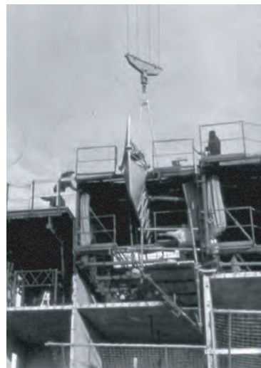
Figura 26. Collocamento in opera dei tunnel Fonte: P. Barucci, 200, volume 4, p. 8
