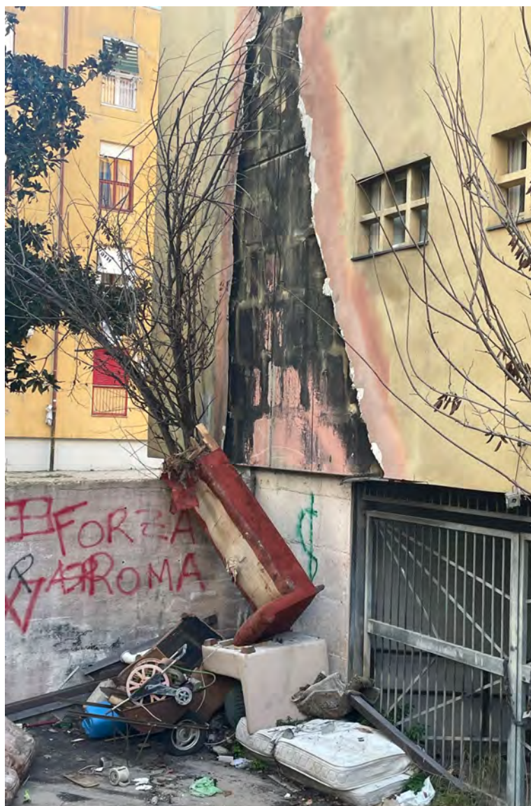
Figura 49 | Quartaccio 2023. Via Flaubert rampe di accesso ai garage.
