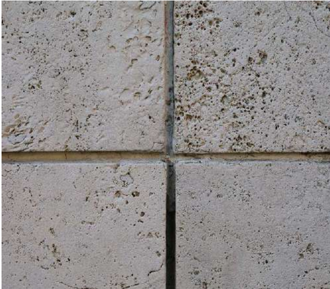
Fig. 36/ La disposizione "a sorella" delle lastre in travertino della facciata principale.
