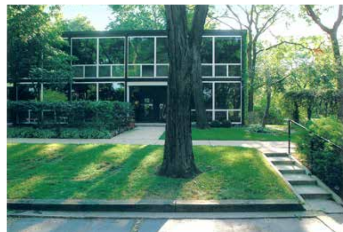
figg. 4.54, 4.55 - Ludwig Mies van der Rohe, Ludwig Hilberseimer, Alfred Caldwell, Lafayette Park , Detroit. Due soluzioni per il salto di quota: le strade carrabili sono ribassate di circa 4 piedi rispetto agli ambiti pedonali. Le automobili sono parzialmente negate alla vista (in alto: foto Marco Introini, da Del Bo 2013; in basso: foto François Robert, da Waldheim 2004).
