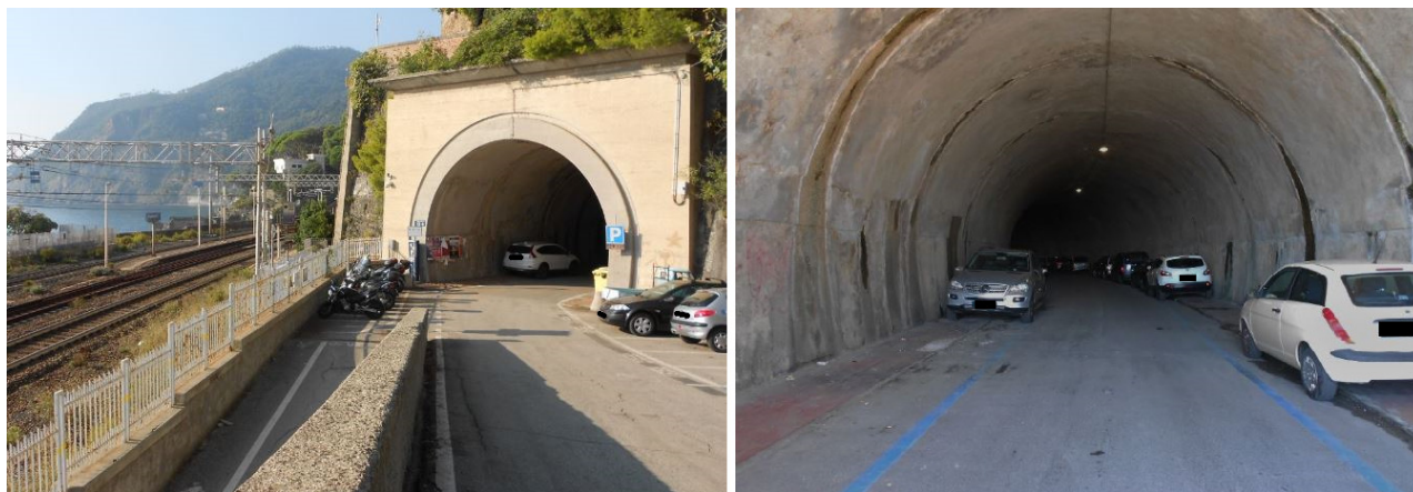
Figura 5.24: fotografie dell'imbocco sud della galleria stradale di Framura (SP)
