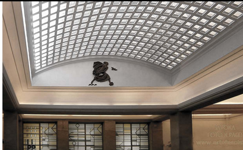
Vista della volta in vetrocemento del Salone per il Pubblico
