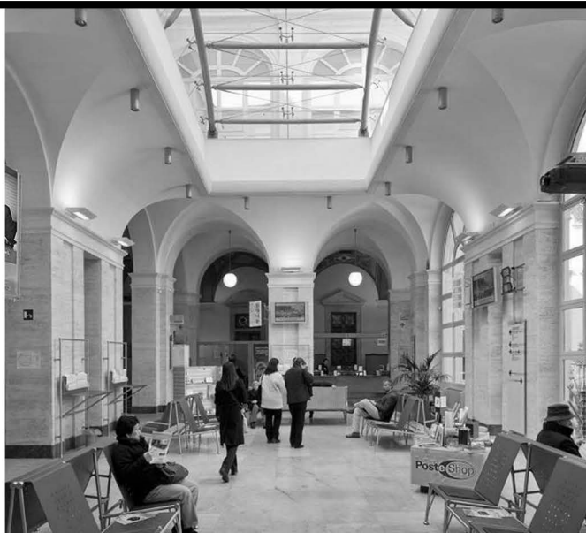
VISTA DELLA COPERTURA PARZIALE DEL CORTILE
