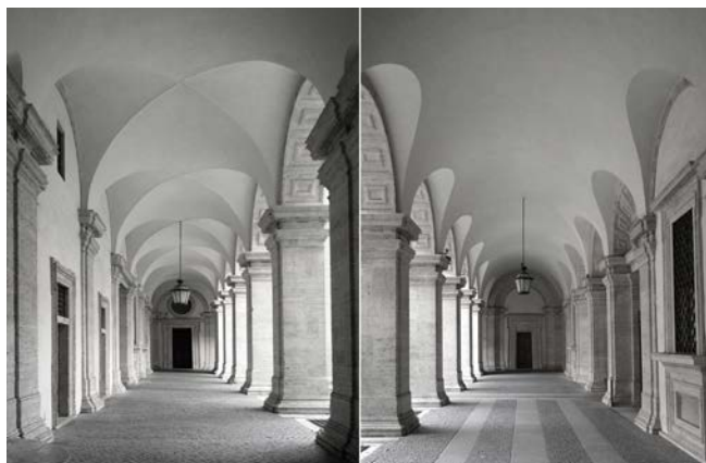
Fig. 10/ Volta a crociera e volta a botte con lunette cilindriche dei portici del cortile di Palazzo Farnese in Roma (per gentile concessione dell'Ambasciata di Francia).
