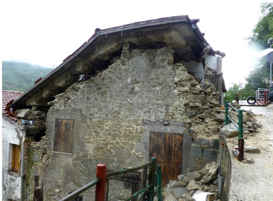
Fig. 15. Replaced reinforced concrete roofs: a) Arquata del Tronto, Pescara del Tronto; b) Amatrice, San Tomasso.
