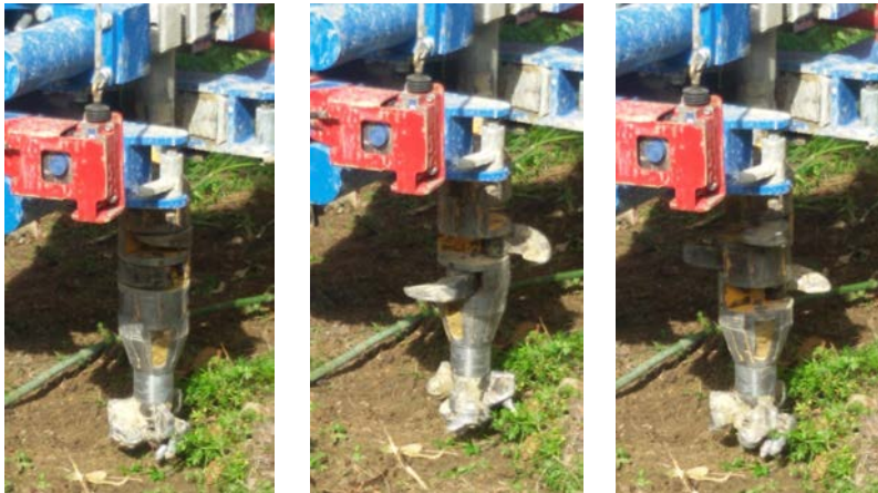
Esecuzione di trattamenti colonnari con impiego di utensile apribile: utensile chiuso e aperto
