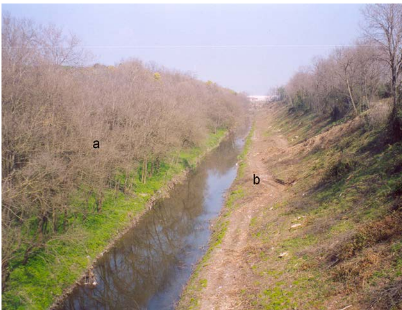
Fig. 6 - Immagine del Rio Martino del 2008, prima (a) e dopo (b) un intervento di 'pulizia' delle sponde realizzato dal Consorzio di Bonifica dell'Agro Pontino. Con l'esclusiva gestione idraulica viene annullato il possibile ruolo di corridoi ecologici dei corsi d'acqua. (foto di Giovanni Mastrobuoni)
