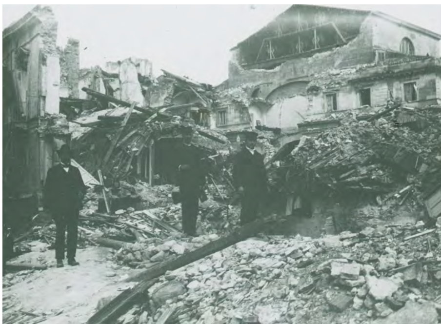
Fig. 46 – Messina, case distrutte dal terremoto.
