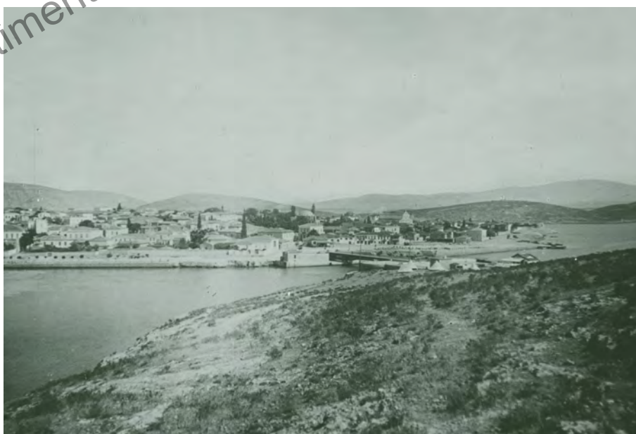
Fig. 6 - Ponte di ferro che congiunge Calcide alla terra ferma (Grecia).
