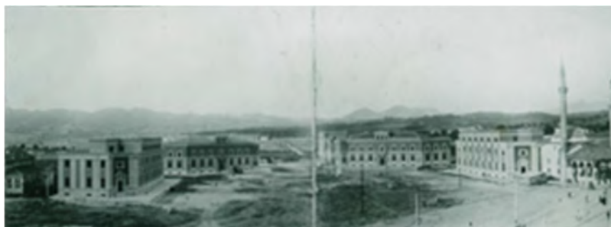
Fig. 2 – Tirana, il centro con i palazzi amministrativi in costruzione (Albania).
